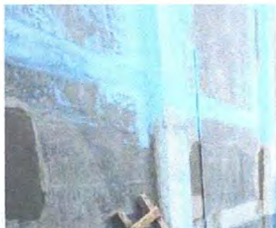
Foto 5: mejoramiento acabado en muro
