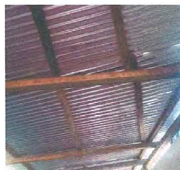
mejoramiento en acabado de techo
