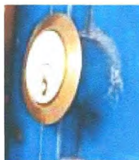
Foto 4: sustitucion de chapas instaladas
