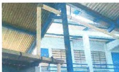
Foto 3: cambio de tubería
