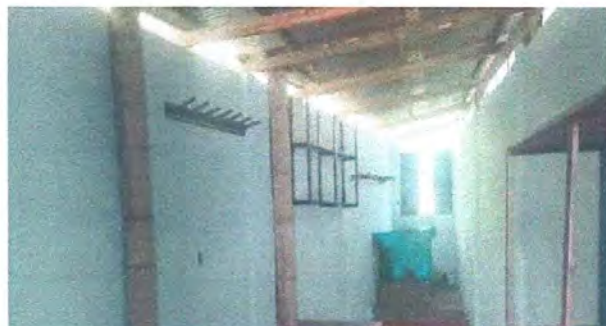
Foto1: Reflejo de la pintada de las paredes de la cocina, terminado.
