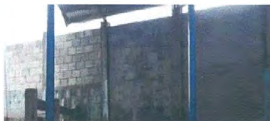
Foto 4: Sustitución y colocación de muro
