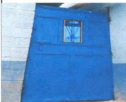
Foto 3: sustitucion de puertas instaladas
