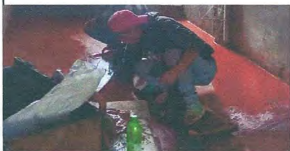
Foto 3: reparacion de de piso de cemento liquido
