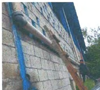
Foto 6: sustitucion tubería de aguas negras
