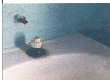
Foto 6: sustitucion de llave de chorro.
