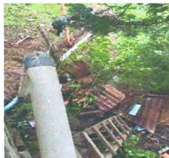
Foto 4: sustitucion de tubería PVC línea principal de aguas negras
