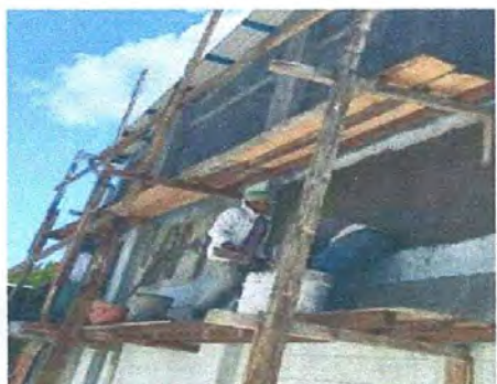
Foto 3: mejaramiento acabado de muro
