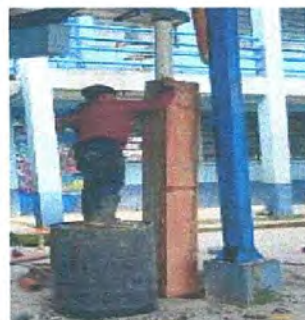
Foto 4: raparacion de bajada pluvial
