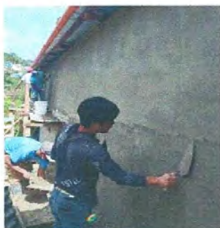
Foto 5: mejoramiento acabado en muro
