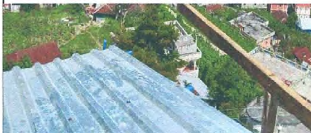
Foto 2: sustitucion de lamina troquelada
