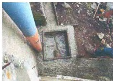
Foto 5: mantenimiento de cajas de registro
