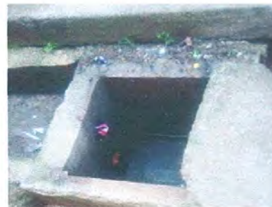
Foto 4: Mantenimiento a cajas de rejistro.
