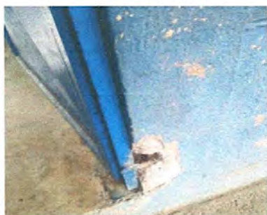
Foto 3: mantenimiento a estructura lijado, cambio de tubo.
