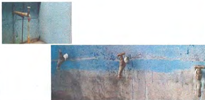
Foto 5: sustitución de llave de chorro
