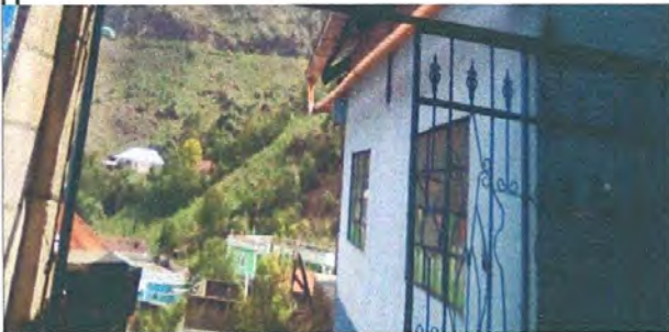
Foto 3: Mantenimientos a portones de metal
