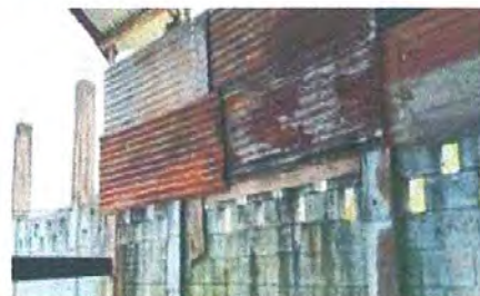
Foto 6: Reparación de muro perimetral de block.
