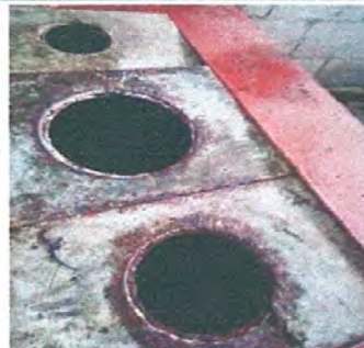
Foto 2: Sustitucion de plancha de metal de tres Hornilla
