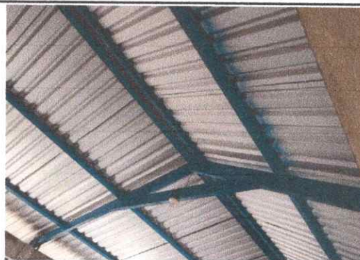
Foto 2: Sustrucción de lamina, por lamina troquelada aluzinc calibre 26 en aulas
