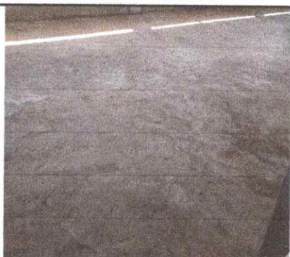
Foto 5: Reparación de piso de torta
