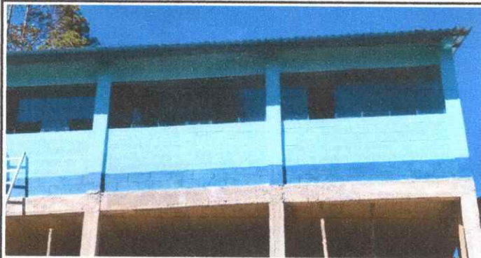
Foto1: Sustrucción de pared de tabia por block en aulas
