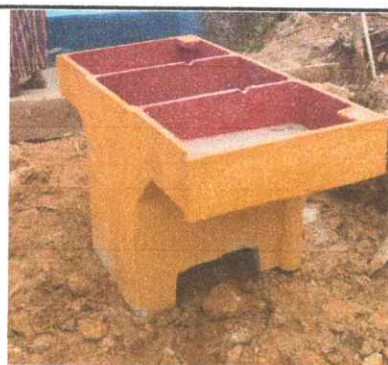
Foto 6: Sustrucción de pila de cemento de 2 lavaderos
