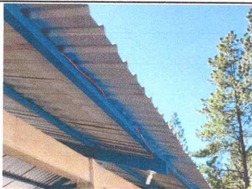
Foto 3: Sustrucción de estructura portante en aulas
