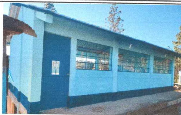
foto 8: Pinturas en muros exteriores e interiores
