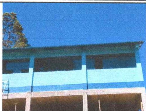
Foto 8: Pinturas en muros exteriores e interiores
