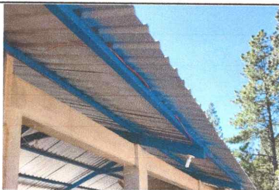
Foto 3: Sustrucción de estructura portante en aulas
