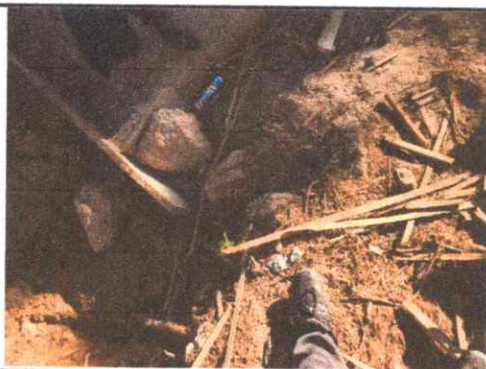
Foto 5: Reparación de piso de torta
