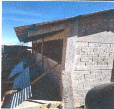
Foto1: Sustrucción de pared de tabia por block en aulas
