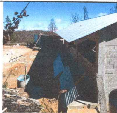
Foto 2: Sustrucción de lamina, por lamina troquelada aluzinc calibre 26 en aulas
