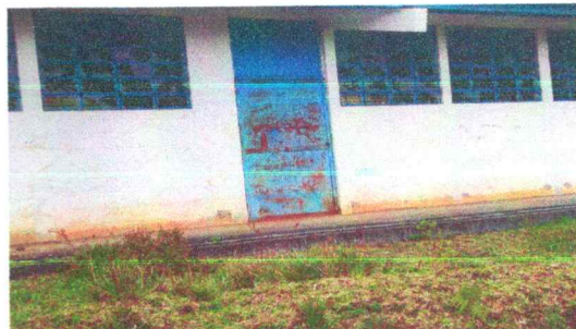
Foto 2: Pinturas en muros exteriores e interiores
