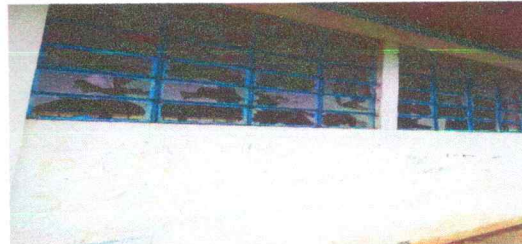
Foto 4: Sustitución de ventanas de madera de metal mas vidrio 320x110
