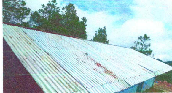
Foto 2: Sustitución de lámina, por lámina troqueada aluzinc calibre 26 en aulas
