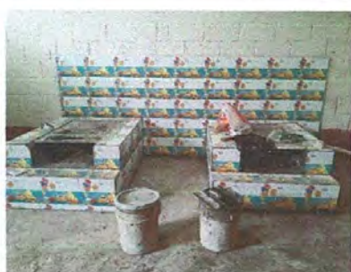
Foto 5: cambio de las 2 estufas rurales completas
