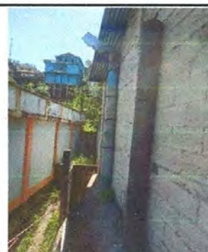
Foto 4: Cambio de tubo de chimneas de conrceto.
