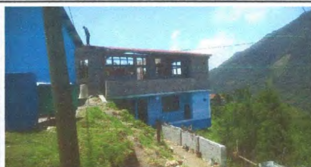
Foto 2: Finalización de la colocación de techo laminas troqueladas calibre 26 color rojo.
