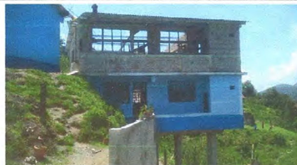
Foto 4: Sustitución y colocación de muro de contención en la entrada del aula.
