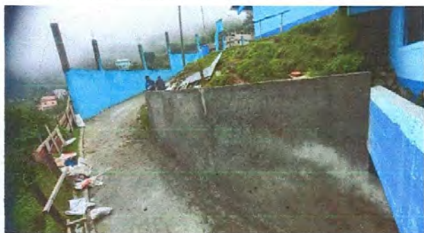
Foto1: Terminación de mejoramiento de muro de contención.
