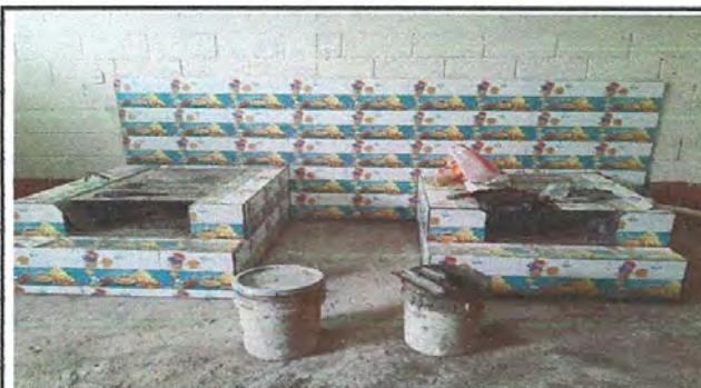
Foto 6: Cambio y mejoramiento de estufa rural por completo con la colocacion de azulejos con figuras.
