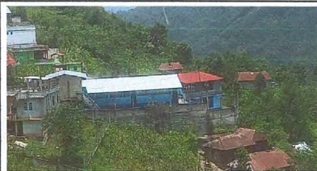
Foto 3: Panorama de mejoramiento y colocación del techo, lamina troquelada
