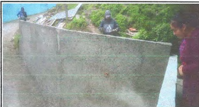
Foto 3: Finalización del muro de contención.
