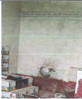
Foto 1: Pintada de las paredes
