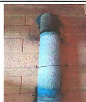
Foto 4: Cambio de tubo de chimneas de conrceto.
