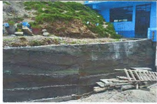
Foto 4: Sustitución y colocación de muro de contención en la entrada del aula.
