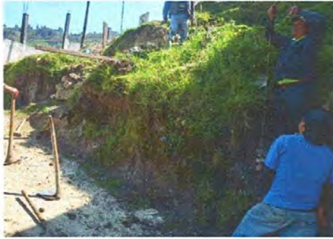
Foto1: Colocación de muro de contención.
