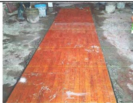
Foto 6: colocación de piso ceramica en la cocina.
