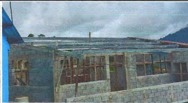
Foto 3: mejoramiento de estructura de sostenimiento de techo.
