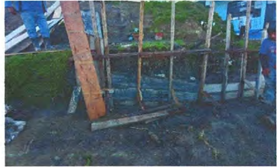
Foto 2: Inicio e colocación de muro de contención.
