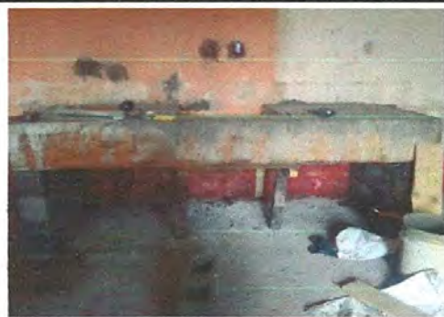
Foto 2: Mejoramiento de lavatrastos.
