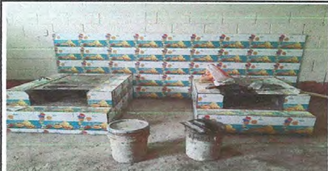
Foto 6: Cambio y mejoramiento de estufa rural por completo con la colocacion de azulejos con figuras.
