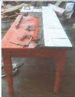
Foto 5: Colocación de piso ceramica en mueble de la cocina.
