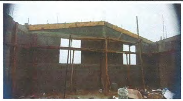
Foto 4: mejoramiento de paredes para colocar y mejorar techo de lamina troquelada calibre 26.
