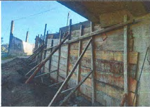
Foto 3: Mejoramiento de muro de contención.
