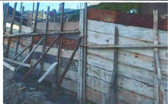
Foto 6: mejoramiento del muro de contención y acceso de entrada en riesgo.
