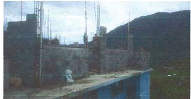
Foto 4: mejoramiento de techo lamina troquelada calibre 26
