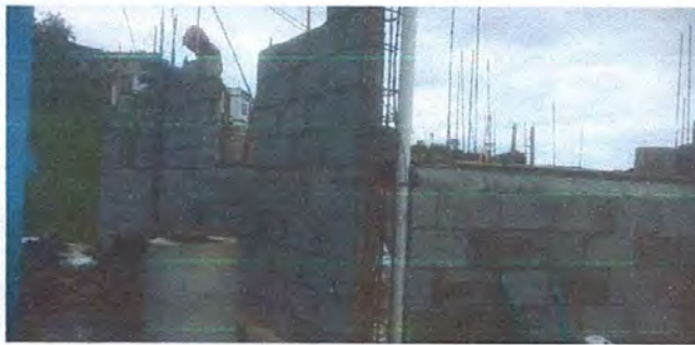
Foto 3: mejoramiento de estructura de sostenimiento de techo.
