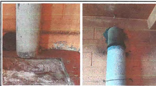
Foto 4: Cambiar las chimeneas de concreto, sacarlo a fuera
