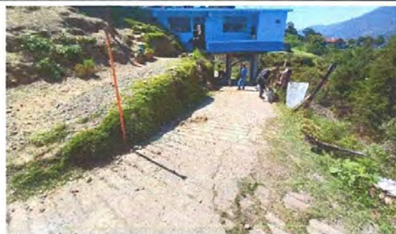
Foto 2: Colocación de muro de contención y mejoramiento de calle de acceso del centro educativo.
