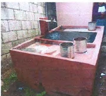
Foto 5: mejoramiento e instalacion de pila plastica
