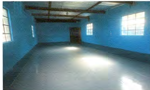
Foto 2: Colocación de piso de cerámico en aula para trabajar de manera digna.
