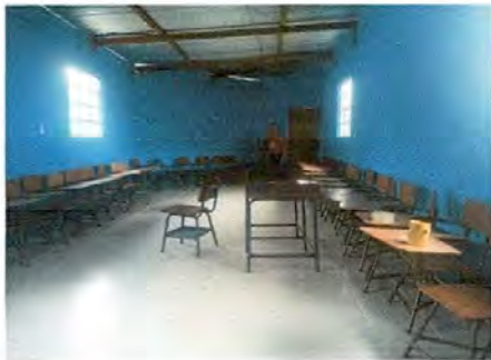
Foto 9: Modulo renovado, repellada, pintada y con piso cerámico.
