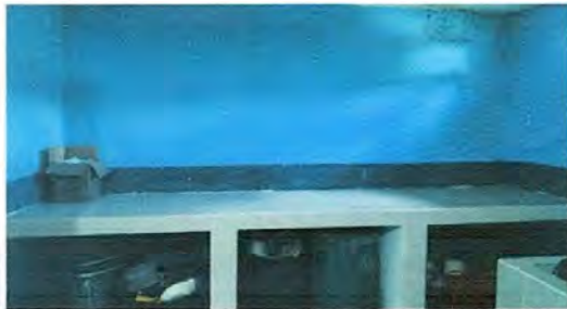
Foto 7: Cocina, mesa totalmete transformada y renovada con materiales modernos para su uso.
