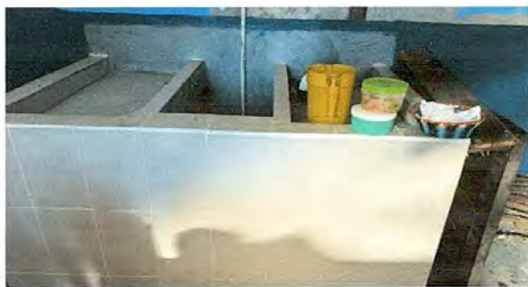
Foto 3: Se finaliza con pila moderna y forrada de azulejo para su buen uso en lavado y almacenamiento de agua.
