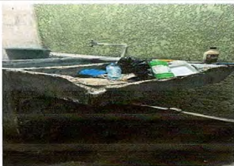
Foto 3: La pila se encuentra quebrada y rajada por lo que no permite almacenamiento de agua.
