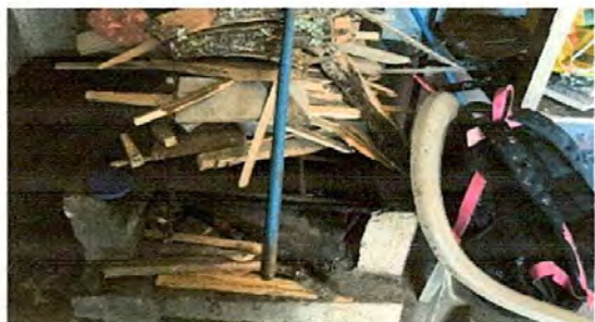
Foto 1: La estufa rural se encuentra totalmente fuera de uso ya que los simientos ya estan rajados.
