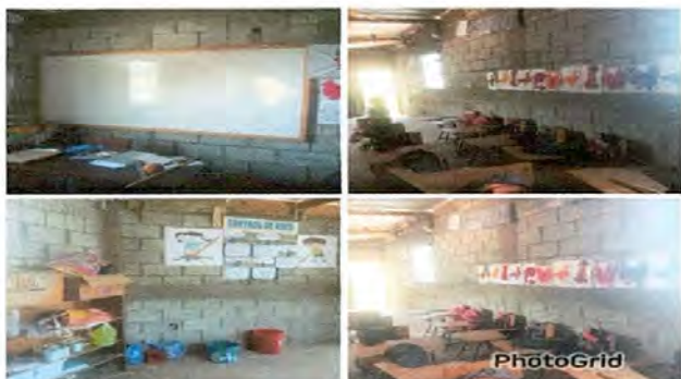
Foto 9: las paredes necesitan repello para evitar filtracion y humedad.
