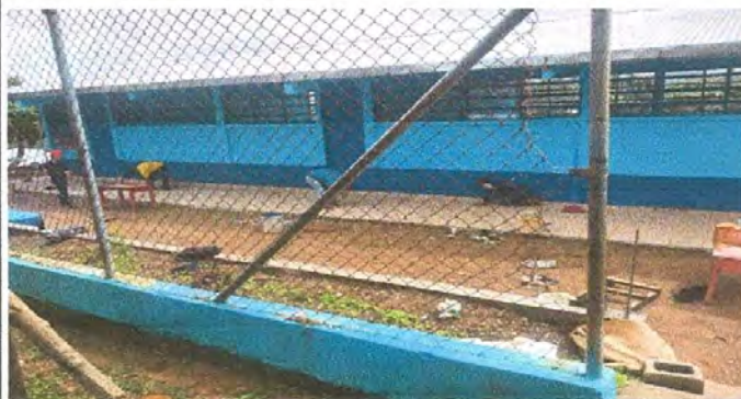
Foto 1: Pintura de la escuela y muro perimetral.
