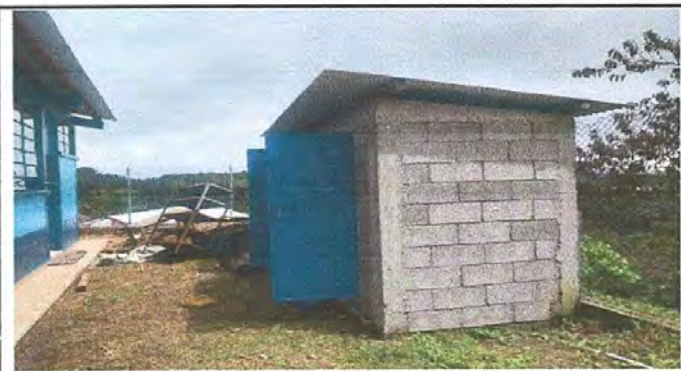
Foto 6: Instalacion de puertas y tazas de los sanitarios
