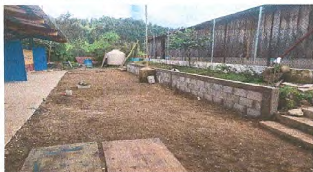
Foto 3: Reconstrucción del muro del jardín escolar
