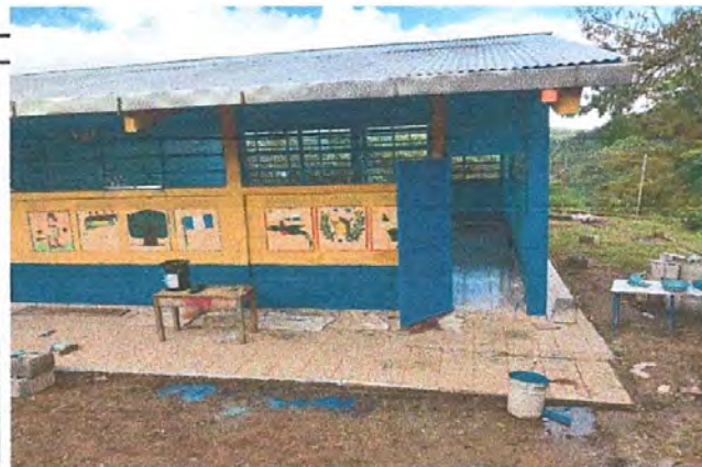
Foto 4: mejoramiento de puertas de puertas y colocacion de canales para recoleccion de agua de lluvia
