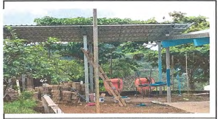
Foto 4: Reconstrucción de galera de madera a galera de estructura metálica
