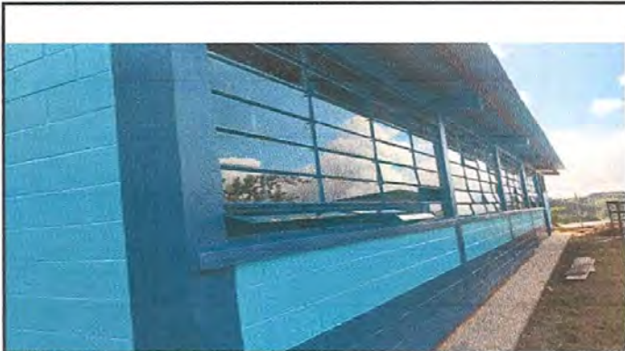
Foto 3: Reparación de ventanales y colocación de vidrios
