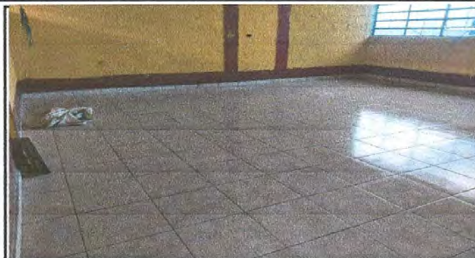
Foto 2: Cambio de piso de torta de cemento a piso cerámico.
