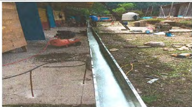
Foto 1: Construcción e instalación de canales de bajada de agua de lluvia.
