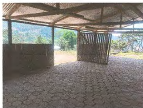
Foto 4: mejoramiento de porton y puertas del establecimiento.
