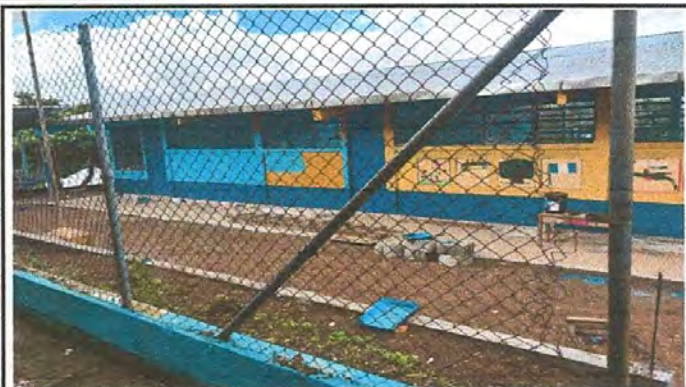
Foto1: Pintura de la escuela y muro perimetral.
