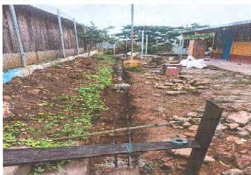
Foto 3: Reconstrucción del muro del jardin escolar
