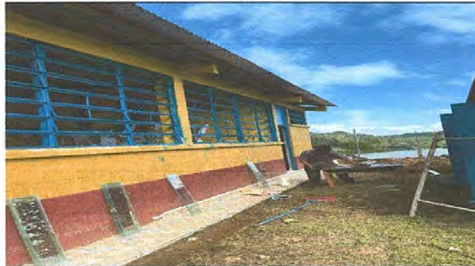
Foto 2: Cambio de vidrios y mantenimiento de ventanales.
