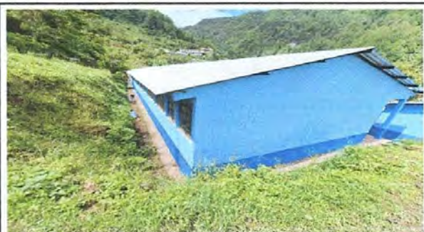
Foto 9: MODULO 1. Se presencia la pintura tanto del exterior e interior de las aulas del centro educativo por lo que fue necesario pintarlo.
