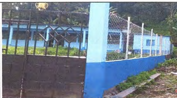
Foto 4: Se aprecia el muro perimetral, en su completa remodelación, la cual impide el acceso de animales domesticos al centro educativo. Lado derecho.
