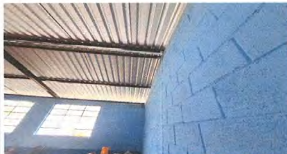
Foto 8: COCINA. Se observa el interior y exterior de la cocina ya pintada y terminada.
