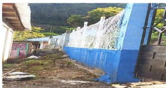
Foto 3: Se puede apreciar el muro perimetral en su completa remodelación lado izquierdo.
