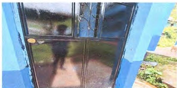
Foto 7: COCINA. Se aprecia la puerta principal de la cocina con su puerta y chapa nueva.
