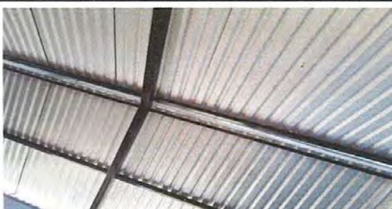
Foto 5: COCINA. Se observa la cubierta de lámina con soporte de metal, ya remodelado
