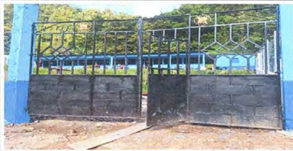
Foto 1: Vista del acceso principal de la escuela. Al MODULO 1. Aldea Yalambolop, San Mateo Ixtatán, Huehuetenango
