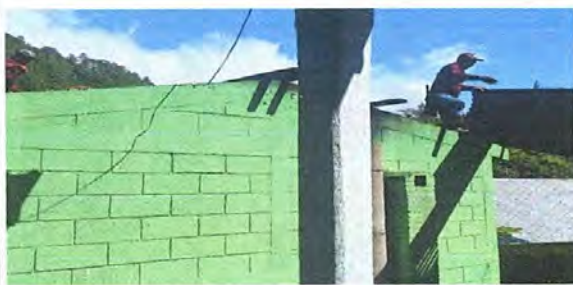
Foto 5: COCINA. Se observa el cambio de la cubierta de lamina con soporte de madera, en proceso.
