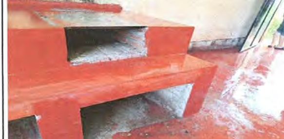
Foto 6: COCINA. Se aprecia el cambio y construcción de la estufa rural, la cual se le esta sustituyendo.
