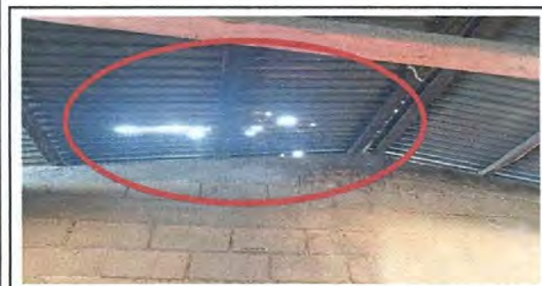
Foto 5: COCINA. Se observa el deterioro de la cubierta de lámina con soporte de madera la cual necesita ser sustituido.
