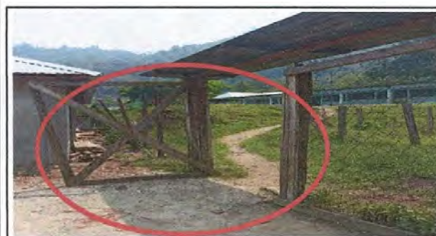
Foto 3: Se puede apreciar el grado de deterioro del portón de maya con soporte de madera lo cual requiere sustitución
