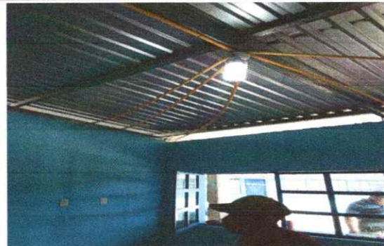
Foto 10: La instalación del cableado eléctrico ha terminado y entregado.
