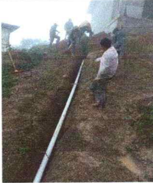
Foto 7: La colocación de la tubería ha finalizado también.
