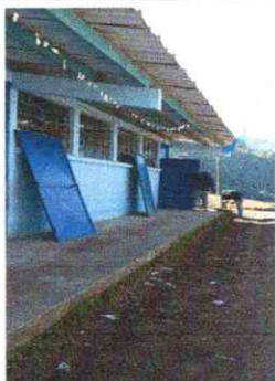
Foto 3: Se están instalando las puertas de las aulas de la escuela.
