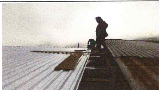
Foto1: se puede observar el entechado de la cocina
