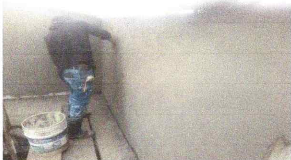
Foto 9: Aquí podemos observar el mejoramiento del repello en paredes.
