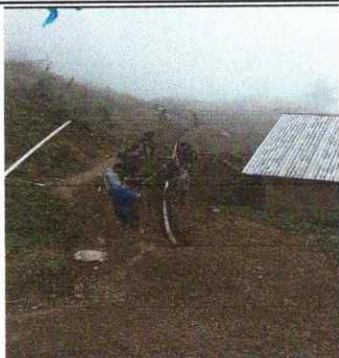
Foto 7: observamos la instalación de Tubería para aguas negras.
