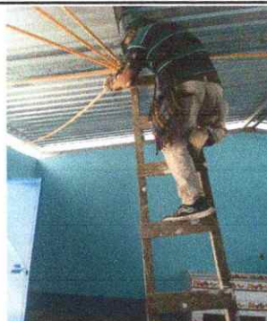
Foto 10: instalación del cableado eléctrico en la cocina y aulas.
