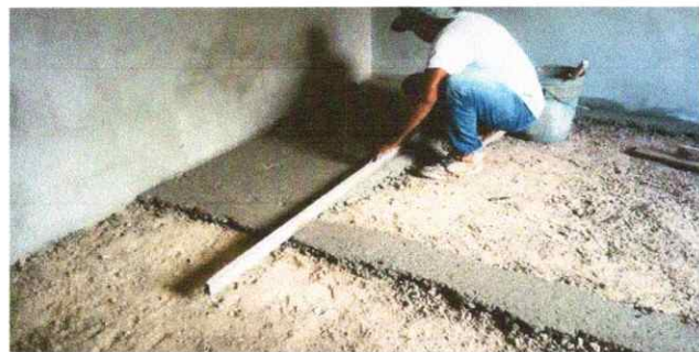
Foto 5: En la fotografía podemos apreciar el trabajo del albañil en la instalación del piso de concreto.
