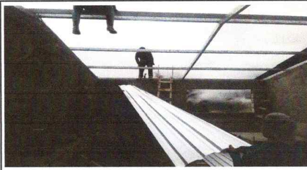
Foto 2: Aquí se puede observar la instalación de la estructura de soporte de techo de la cocina.
