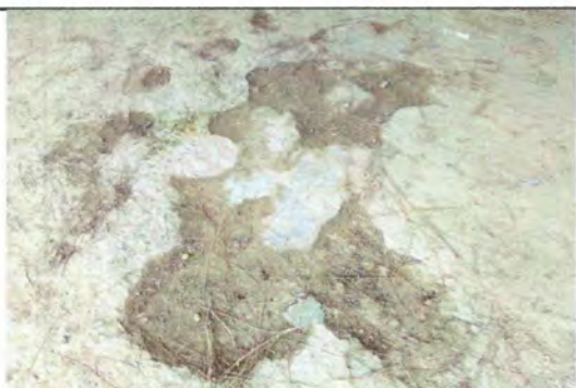
Foto 3: Reparación de losa de patio
