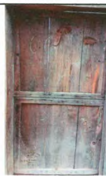
Foto 4: Sustitución de puerta de cocina
