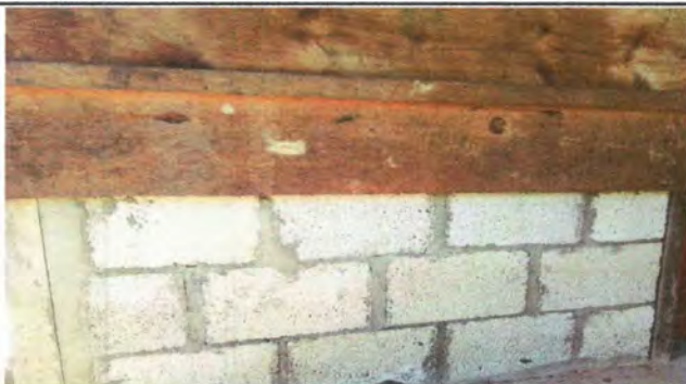
Foto1: Mejoramiento paredes de cocina
