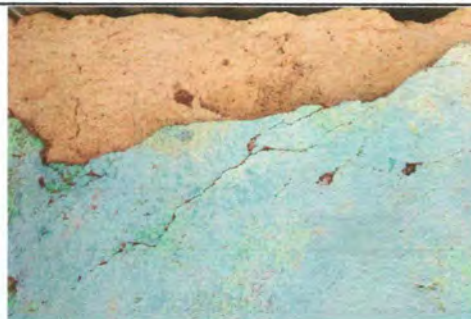
Foto 6: Reparación de repello en muro
