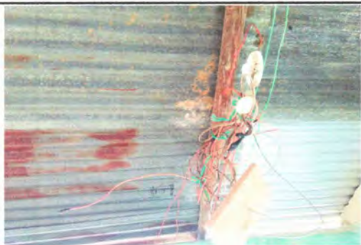
Foto 11: Reparación de cableado eléctrico
