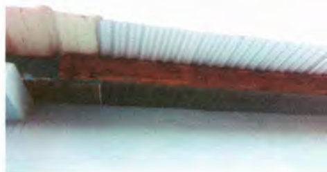
Foto 12: Sustitución de estructura de soporte de techo
