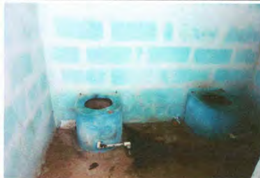
Foto 8: Sustitución de inodoro.
