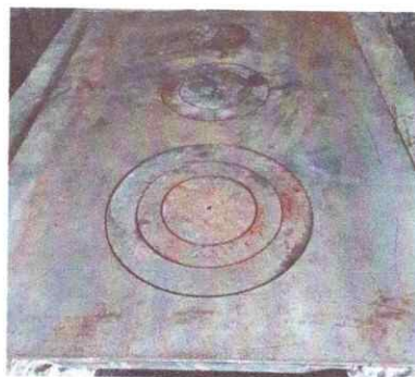
Foto 2: sustitucion de plancha y chimenea
