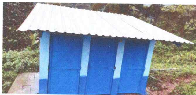
Foto 6: sustitucion del techo de servicios sanitario
