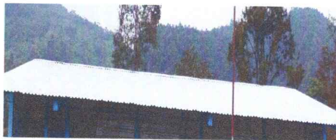
Foto 4: sustitucion de techo de la escuela
