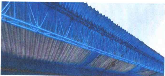
Foto 5: mantenimientos de la estructura de la escuela
