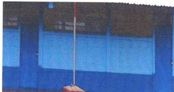
Foto 7: Mejoramiento de puertas
