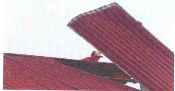
Foto 6: sustitucion del techo de servicios sanitario
