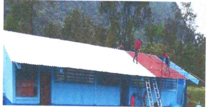
Foto 4: sustitucion de techo de la escuela
