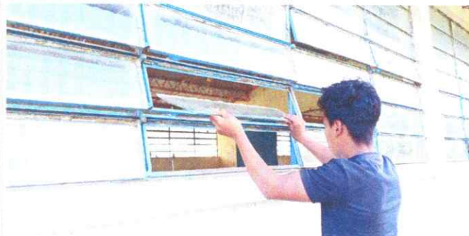
Foto 8: mejoramiento de vidrios
