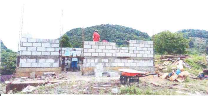
Foto1: Mejoramiento paredes de cocina de madera a bloCk
