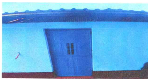
Foto 4: puerta de cocina sustituida
