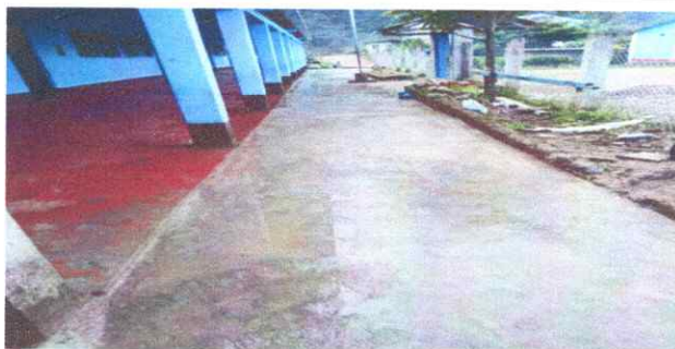
Foto 1: Loza de patio reparado
