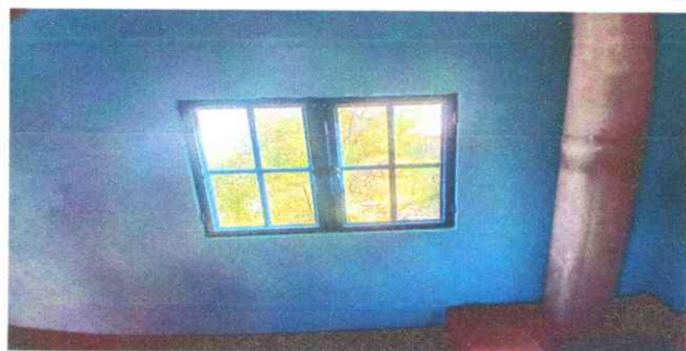
Foto 3: ventana de cocina sustituida
