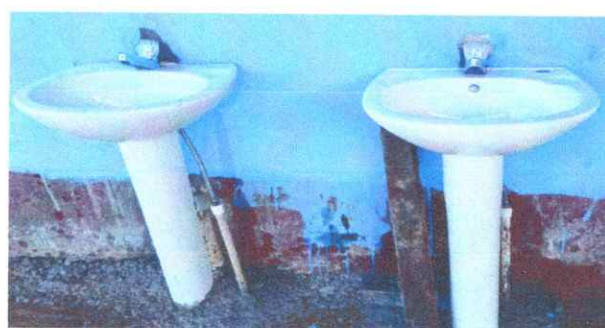
Foto 14: Lavamanos totalmente instalados.
