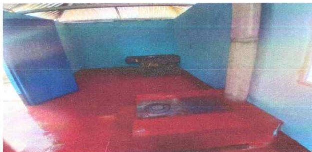
Foto 11: Piso de la cocina totalmente renovado
