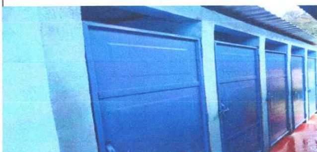
Foto 9: Puerta de baños totalmente sustituida
