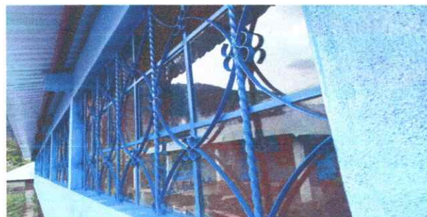
Foto 10: Ventana trasera de la escuela totalmente renovado
