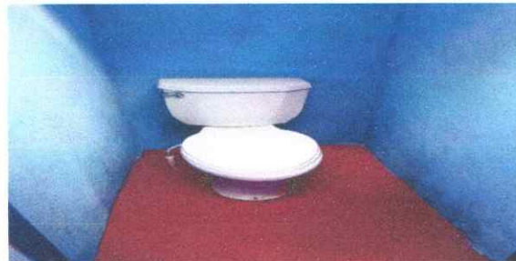
Foto 8: Taza de baño sustituida.
