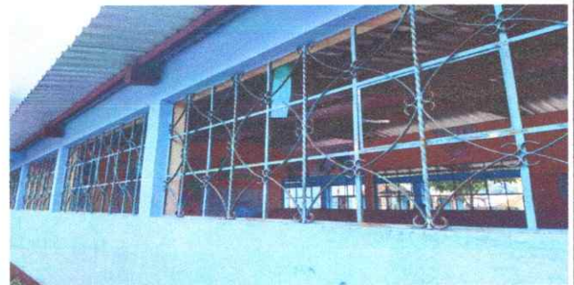
Foto 4: Remocion de vidrios en ventanas para dar mantenimiento a la estructura de metal
