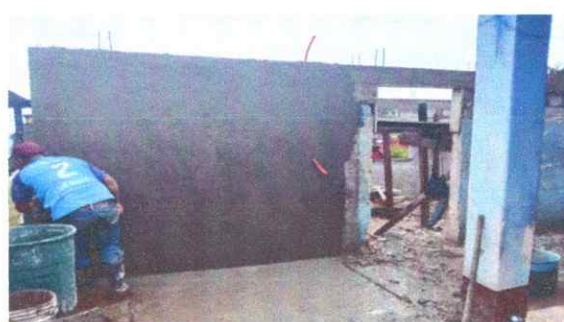
Foto 10: Repellado de pared de cocina
