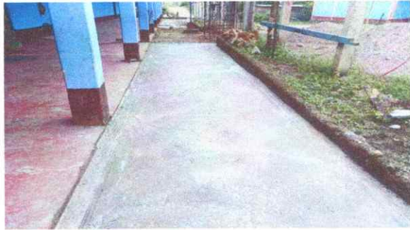
Foto 1: Reparacion de loza de patio
