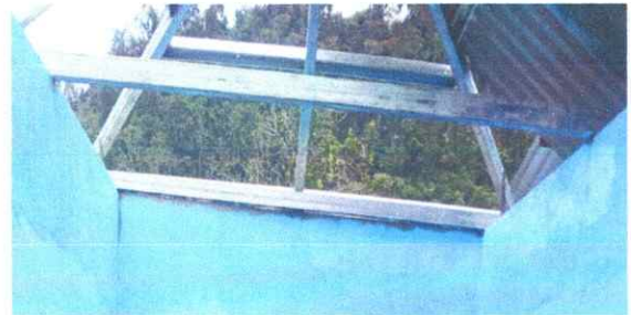
Foto 6: armado de la estructura de metal y colocacion de las primeras láminas
