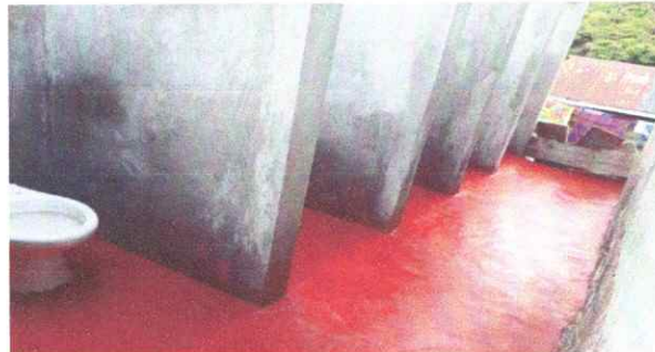
Foto 8: paredes de baños listos para ser pintados
