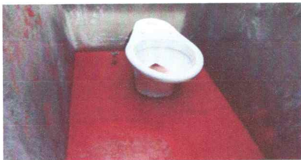
Foto7: sustitucion de piso de baño
