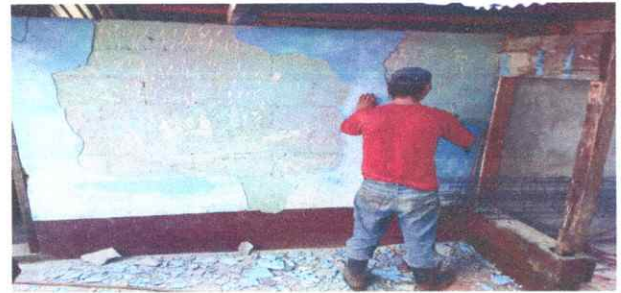
Foto 2: Preparacion de pared para el repellado
