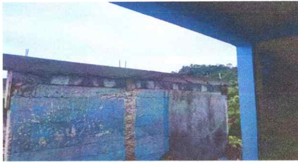
Foto 3: Colocacion de una hilada de block y corona en cocina
