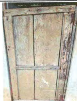
Foto 6: Sustitucion de puerta de baños que están deterioradas
