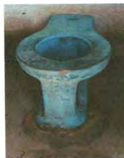
Foto 10: Sustrucción de inodoros
