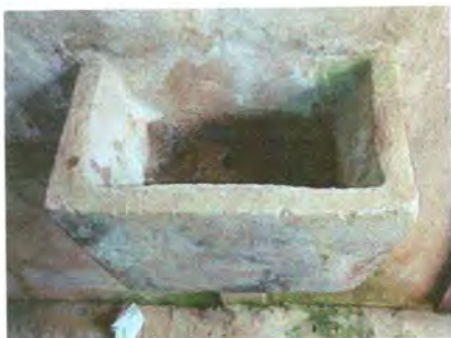
Foto 7: Sustrucción de lavamanos
