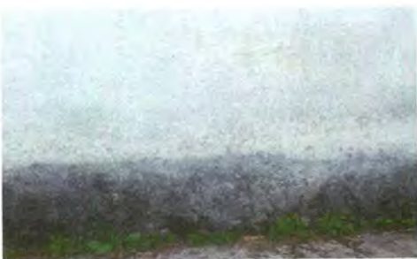
Foto 1: Repello de la pared de cocina
