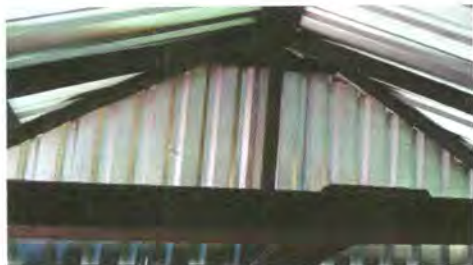
Foto13: Sustrucción de estructura de soporte de techo
