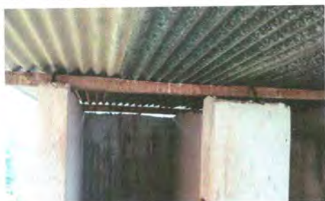
Foto 9: Sustrucción de estructura de soporte de techo
