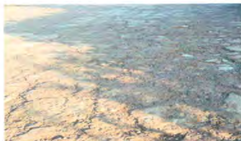
Foto 14: Reparación de losa de patio
