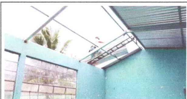
Foto 3: en está fotografía se estan instalando las costaneras de metal chapa 16.
