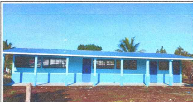
Foto1: en la fotografía se puede apreciar que las laminas ya fueron sustituidas por láminas Aluzinc calibre 26.
