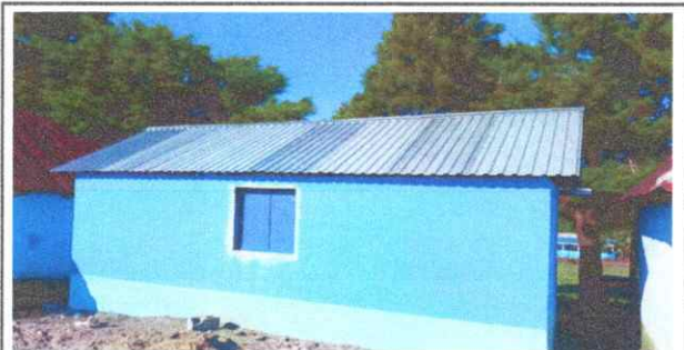
Foto 5: la cocina fue sustituida por pared de block,lamina troquelada aluzinc calibre 26,capotes troqueladas y puerta.
