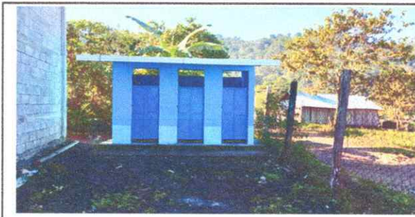
Foto 6: en esta fotografía los baños fueron remodelados, puertas,láminas por láminas troqueladas Aluzinc calibre 26 y canales de agua y pintura en muros exteriores e interiores.
