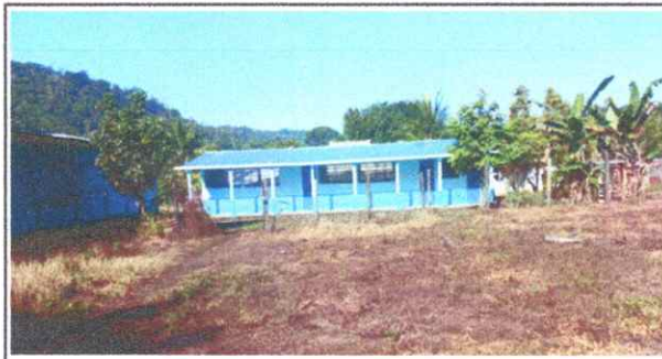
Foto 2: en esta fotografía podemos apreciar que ya la cubierta de láminas y capotes ,ya fueron sustituidas por los capotes troqueladas marca aluzinc calibre 26.
