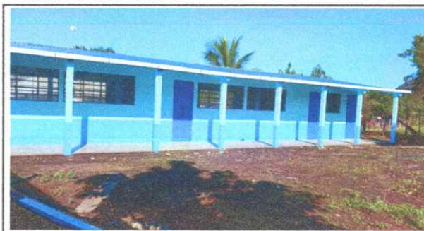
Foto 4: se puede apreciar que las puertas ya fueron colocadas en cada aula.
