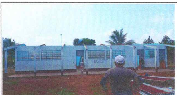
Foto 3: en está fotografía se puede visualizar que ,las costaneras de maderas ya fueron retiradas de su lugar .
