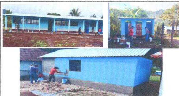
Foto1: en la fotografía podemos apreciar que se esta pintando en la parte exterior e interior de aulas , baños y cocina.
