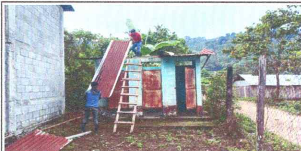
Foto 6: en esta fotografia podemos apreciar que se le está quitando las laminas a los baños , también la madera y las puertas.
