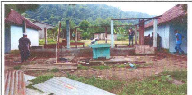
Foto 5: en esta fotografia se puede apreciar que los señores ya retiraron la madera que tenía la cocina , también lo que es lamina y bigas de madera y puerta
