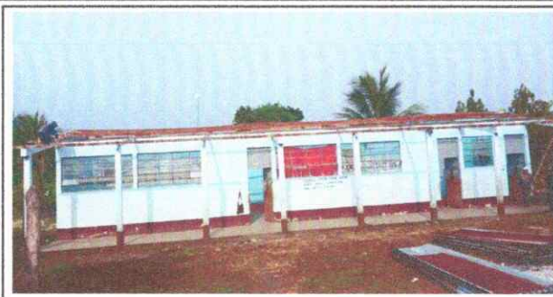
Foto 2: en esta fotografía podemos apreciar que ya la cubierta de láminas y capotes ,ya fueron quitadas por los señores encargados de la mano de obra.
