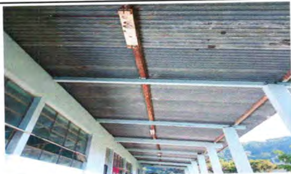
Foto 3: sustitución de estructura de madera por estructura de metal, es necesario cambiar las reglas y tijeras que sostiene el techo, porque ya están desgastados y picados por el agua que ingresa de la lámina y el capote
