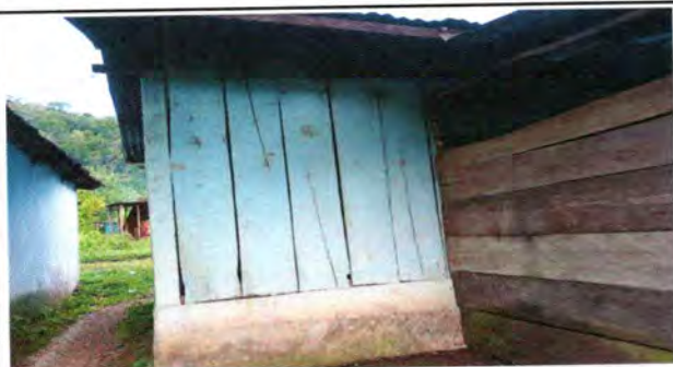
Foto 5: Mejoramiento de pared de madera por Block, es necesario mejorar las condiciones donde se preparan los alimentos de nuestros estudiantes, eso influye en el aspecto social del proceso educativo.
