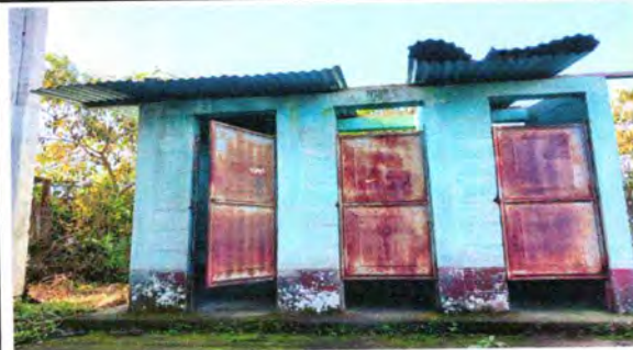
Foto 6: Sustitución de puertas al servicio sanitario, se puede apreciar en la fotografía que este servicio está en malas condiciones las puertas agrietadas y disfuncionales.
