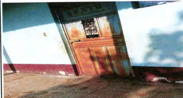
Foto 4: sustitución de puerta. Las puertas ya están en malas condiciones y agrietadas por el paso del tiempo
