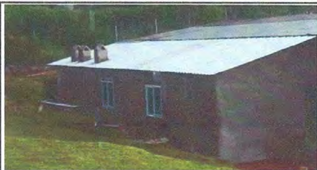
Foto 1. La finalización de trabajos, es de esta manera que la cocina que se remodeló, por lámina troquelada aluzinc calibre 26.
