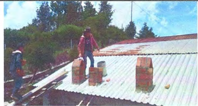
Foto 7.2: Sustitución de chimenea de concreto de la cocina de la Escuela por el albañil se ha terminado.
