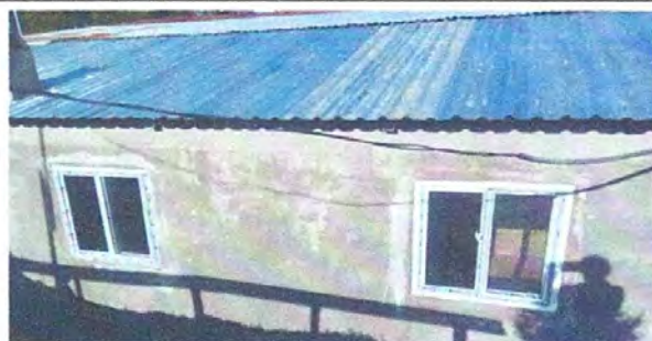
Foto 4: La colocación de las ventanas de metal de 1 metro cuadrado, ya esta colocado por la estructura Metálica Mingo.
