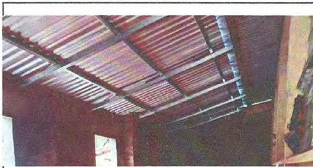
Foto 2: Igual también se cambio la Sustitución de estructura de soporte de madera, por metal.
