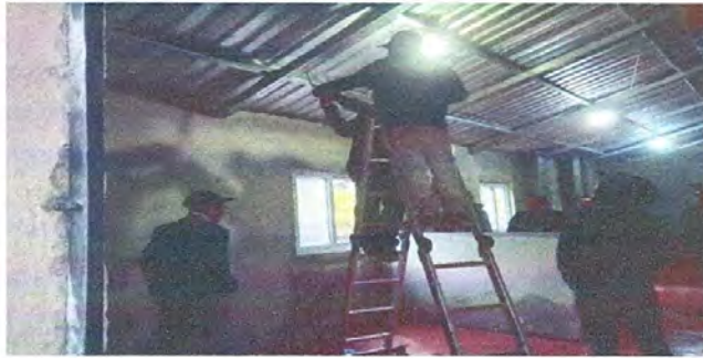
Foto 6: Se culminó el trabajo, de ultimo se esta instalando la luz electrica en la cocina en remozamiento.
