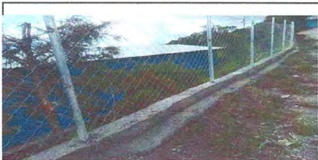
Foto 5: Finalización del muro perimetral.
