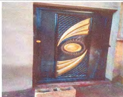
Foto 3: Sustitución de puerta 1 metro de ancho por 2 metros de alto, ya esta colocado por la estructura Metálica Mingo.
