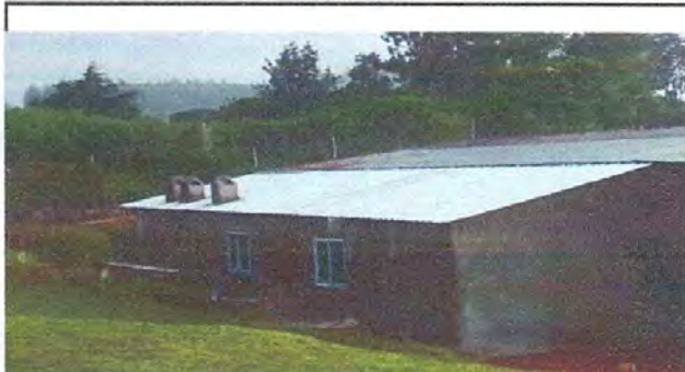
Foto 8: La Cocina de la Escuela Chibalasun, se termino repellido los paredes dentro y afuera de la cocina se finalizo, ya que es una gran necesidad para la preparación de los alimentos.
