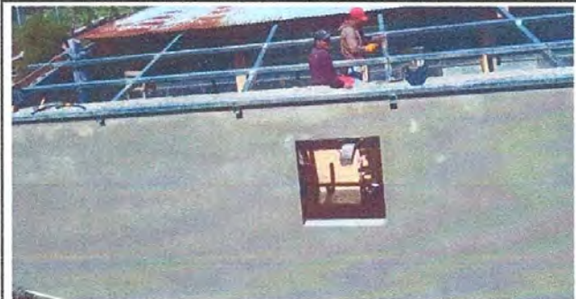
Foto 9.1: La Instalación de estructura portante de metal por el baño y con los OPFs.
