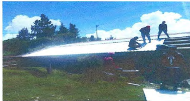
Foto 9: Mano de obra especializada . Sustitución de lámina, por lámina troquelada aluzinc calibre 26, utilizado en la cocina de la Escuela Oficial Rural Mixta de la Chibalasun.
