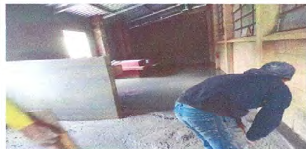
10.1 : Reparación de piso de cemento líquido
