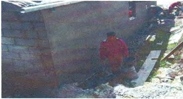
8. Reparación de repello y cernidos de los paredes de la cocina de la Escuela.
