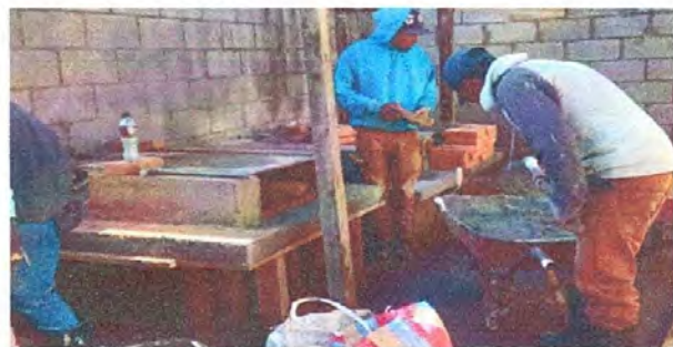
Foto 7.1: Sustitución de estufa rural (completa), En proceso la remodelación y mejoramiento de la cocina de la Escuela Oficial Rural Mixta de la aldea Chibalasun.
