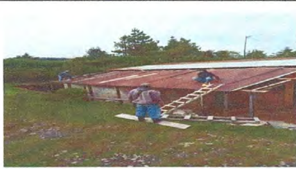
Foto1: La desinstalación de láminas se va cambiar a traves por las láminas troqueladas aluzinc calibre 26, utilizado en la cocina de la Escuela Oficial Rural Mixta de la Chibalasun.
