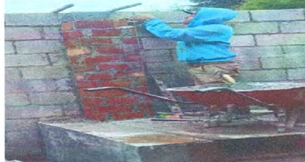
Foto 7.2: Sustitución de chimenea de concreto en la cocina de la Escuela por el albañil solicitado.
