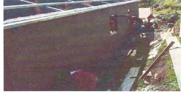
8.1: Reparación de repello de la cocina y cernidos de los paredes.
