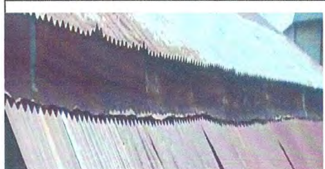
Foto 1.1: Cambio de capote de lámina porque esta por oxidado y dañado hace años por esta razon se cambiara con unos nuevos.
