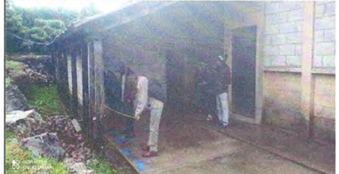
Foto 9: Mano de obra especializada albañilería, La cocina de la Escuela Chibalasun esta muy pequeño, por esta razon se agrandara la cocina igual forma esta en mal estado.
