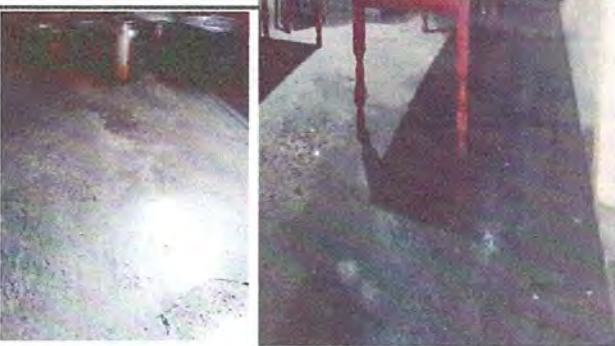
Foto 10: El Piso esta hecho con torta de concreto, por tal razón se va cambiar a través de piso de cemento liquido.
