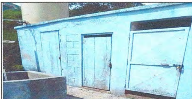
Foto 3.1: Igual manera se cambiara las puertas del Servicios sanitarios porque esta en mal estado, y se utilizara puertas de metal.
