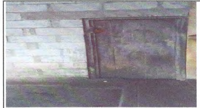
Foto 3 : Sustitución de puerta: la puerta de la cocina esta hecho de madera, por eso se va cambiar en una puerta de metal.
