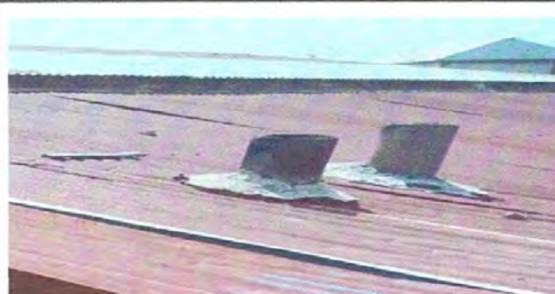
Foto 7.1: También la Cocina de la Escuela Chibalasun, ya no se puede utilizar porque los tuvos de chimenea ya no funcionan y entra mucho agua dentro de la cocina.
