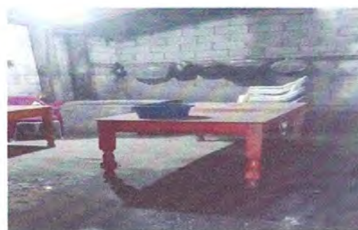
Foto 6: Reparación de sistema Eléctrico, se cambiara los focos de la cocina porque se ve muy oscuro por los focos que ya estan.
