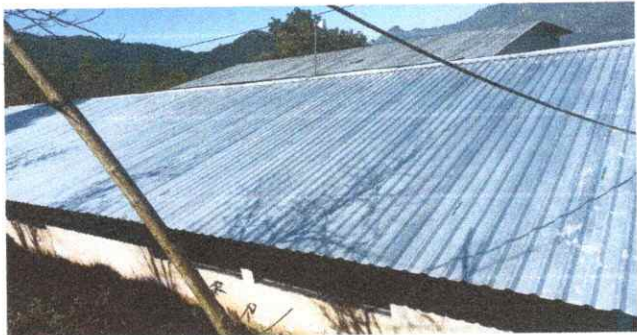
Foto 1: Sustrucción de lámina en mal estado finalizado
