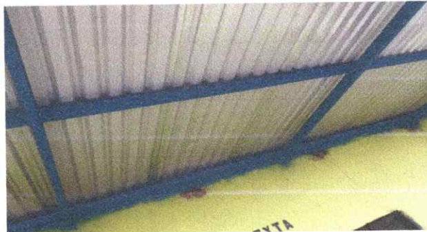
Foto 2: Sustrucción de estructura de soporte de madera por metal finalizado
