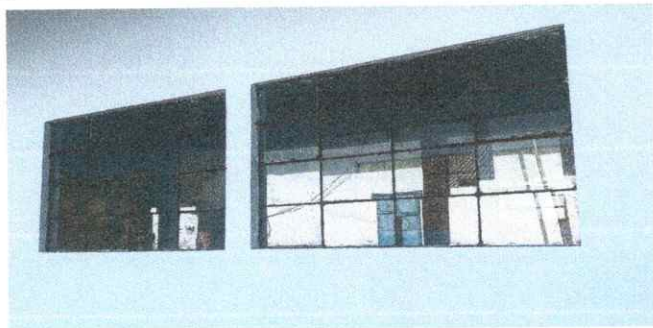
Foto 5: Sustrucción de vidrios en mal estado finalizado
