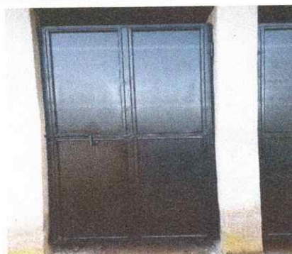
Foto 4: Sustrucción de puertas del baño de madera por metal finalizado
