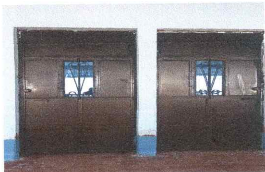
Foto 3: Sustrucción de puertas de metal deteriorado finalizado
