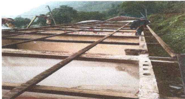
Foto1: Sustitución de lámina en proceso
