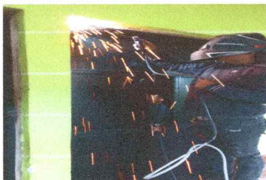
Foto 3: Sustitución de puertas de metal deteriorado en proceso
