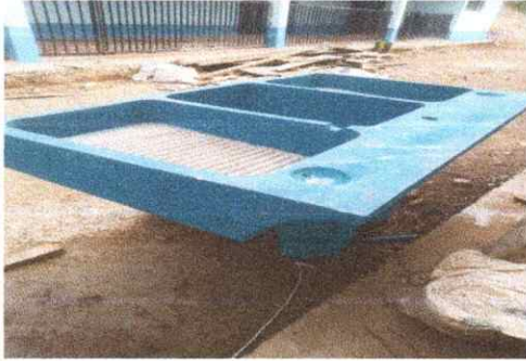
Foto7: Sustitución de pila de cemento en mal estado
