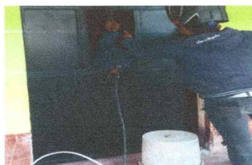
Foto 4: Sustitución de puertas del baño en proceso
