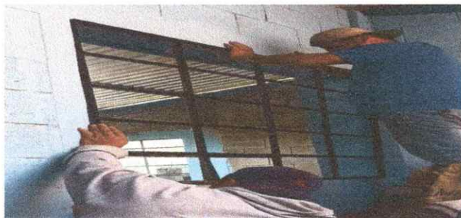
Foto 5: Sustitución de vidrios en proceso
