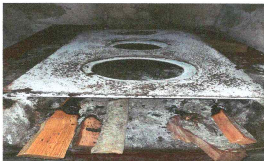
Foto 6: Sustrución de estufa rural en malas condiciones, chimenea deteriorada y plancha oxidada
