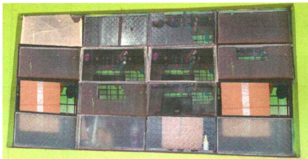
Foto 5: Sustrución de vidrios no adecuados y en mal estado
