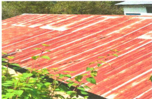
Foto 1: Sustrución de lámina en mal estado y con agujeros
