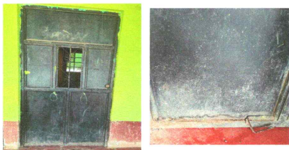
Foto 3: Sustrución de puertas de metal deteriorado o dañado
