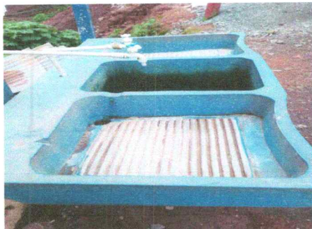
Foto7: Sustitución de pila de cemento en mal estado o deteriorado
