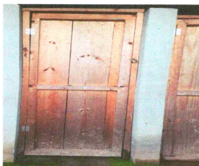
Foto 4: Sustrución de puertas del baño de madera deteriorada
