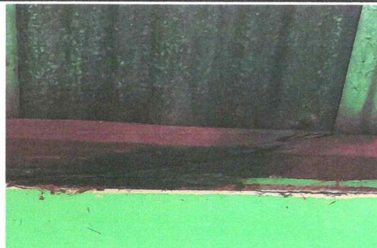
Foto 2: Sustrución de estructura de soporte de madera por metal
