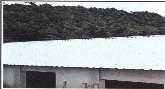
Foto 3: Láminas troqueladas instaladas
