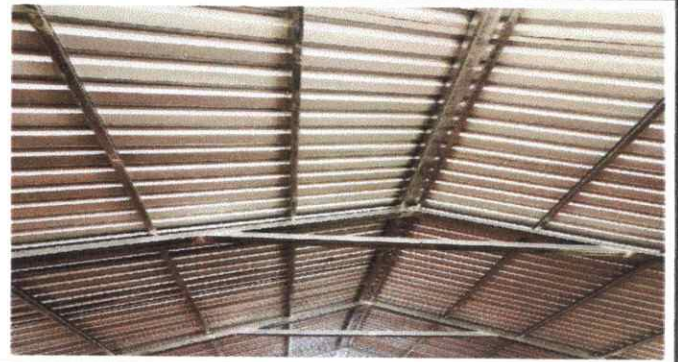
Foto 2: Soporte de metal terminada
