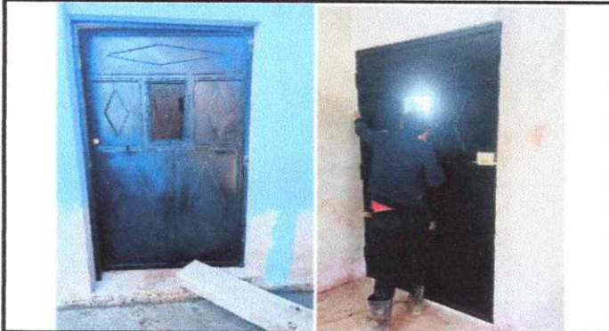
Foto1: Instalación de puertas de metal terminado
