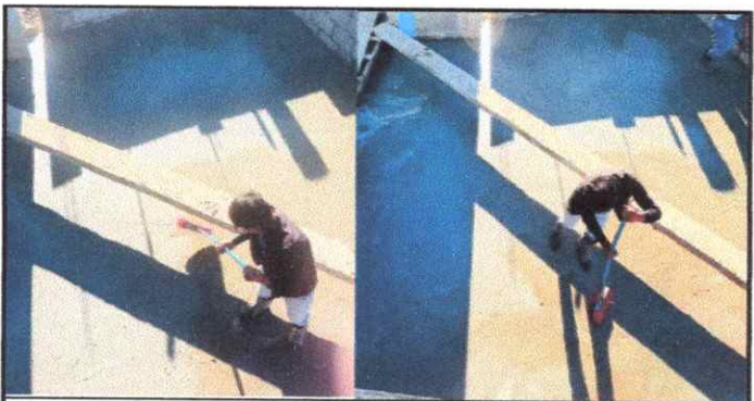
Foto 6: Torta de concreto terminado
