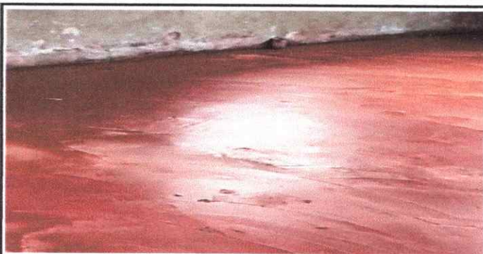
Foto 5: Pizo de cemento liquido terminado dentro de la cocina
