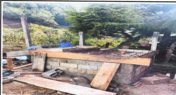
Foto 8: Ejecución de trabajo de una pila de dos lavaderos con cemento líquido, blok y hierro.
