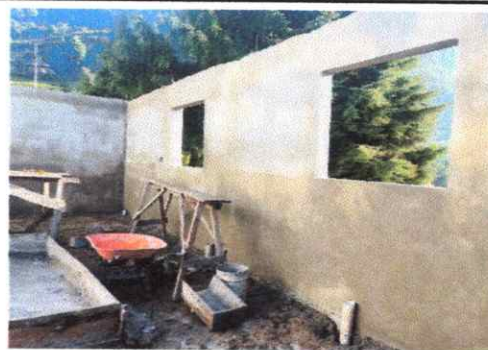
Foto 10: Muro perimetral en proceso
