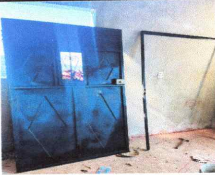
Foto1: Instalación de puertas de metal
