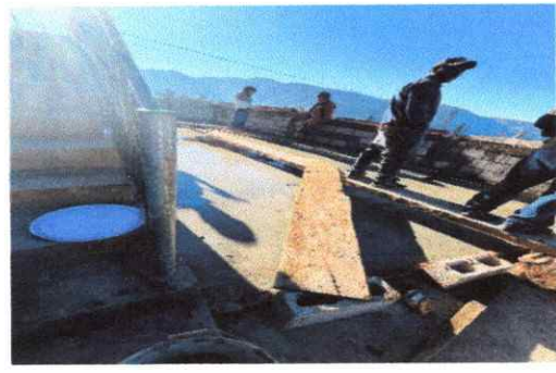
Foto 6: Ejecución de trabajo de piso de torta de concreto.
