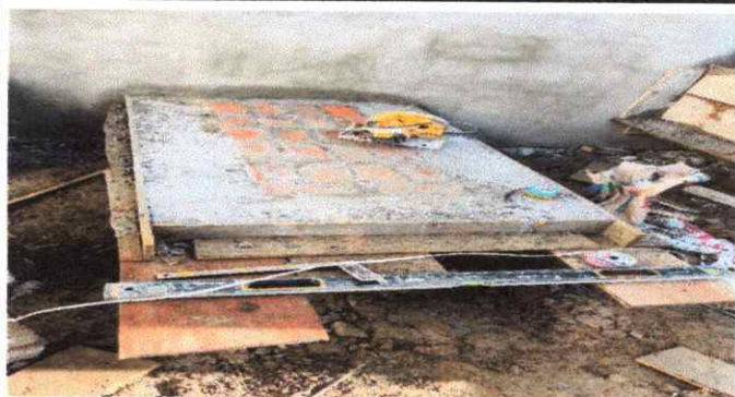
Foto 7: Ejecución de estufa rural con ladrillos y cemento líquido.
