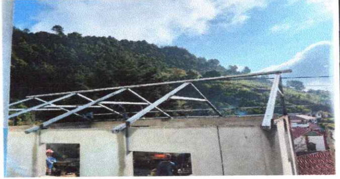
Foto 2: Instalación de techo por soporte de metal.
