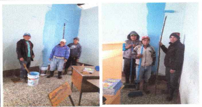
Foto 4: Aplicación de pinturas en interiores y exteriores.
