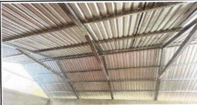
Foto 3: Instalación de láminas troqueladas.
