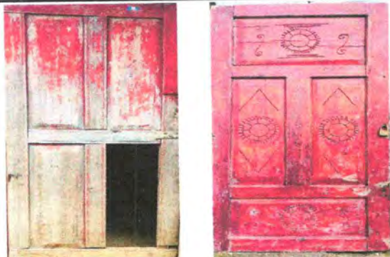
Foto1: Sustitución de puerta de maderan por una de metal
