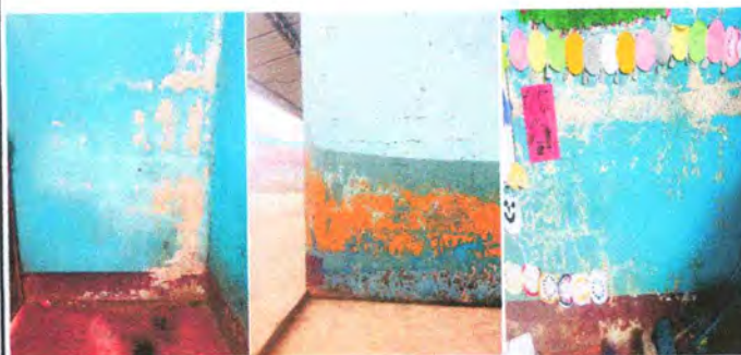
Foto 4: Aplicación de pintura en interiores y exteriores
