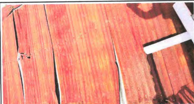
Foto 3: Sustitución de láminas por láminas troqueladas
