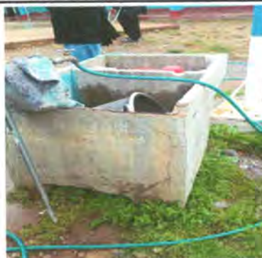
Foto 8: Sustrucción de pila de dos lavadero
