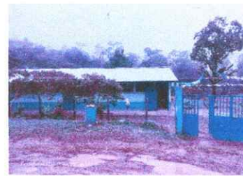
Foto 2: Sustitución de láminas por láminas troqueladas de aluzinc calibre 26.
