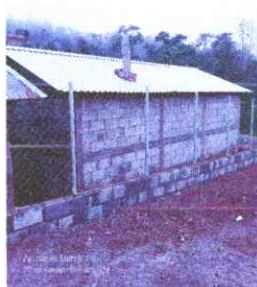
Foto 2: Sustitución de láminas por láminas troqueladas de aluzinc calibre 26.
