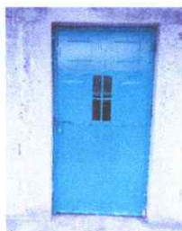
Foto 5: Sustitución de ventanas y puerta de madera por metal.
