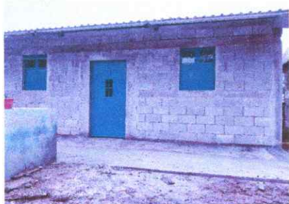
Foto1: Mejoramiento paredes de cocina
