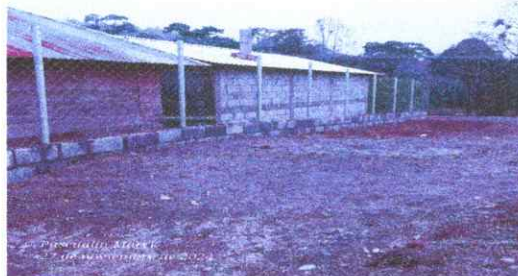
Foto 4: Mejoramiento de muro perimetral.
