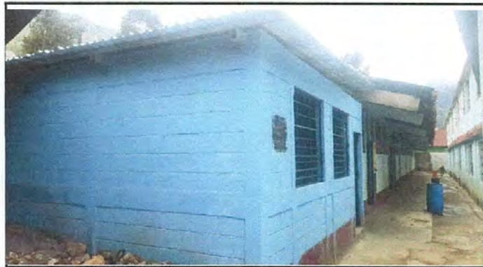
Foto1: Sustitución de lamina, por lámina troquelada finalizada
