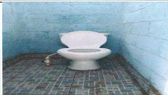
Foto7: SERVICIOS SANITARIOS Y SUS ACCESORIOS. Sustitución de inodoro finalizado
