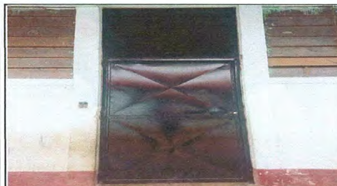
Foto 3: Sustitucion de puerta finalizado
