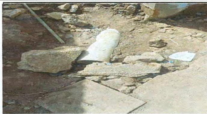
Foto 8: REPARACION DE DRENAJE Y RED DE AGUA POTABLE: Sustitución de tubería PVC finalizado.
