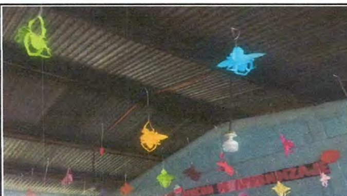
Foto 9: Reparación de sistemas eléctrico finalizado
