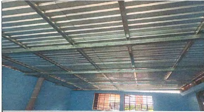
Foto 2: ESTRUCTURA DE TECHO: Sustitución de estructura de soporte de madera, por metal finalizado.
