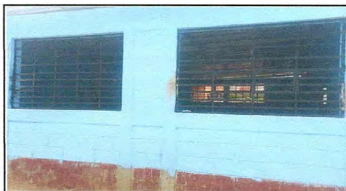
Foto 4: VENTANAS: Sustitución de estructura de ventana finalizada.
