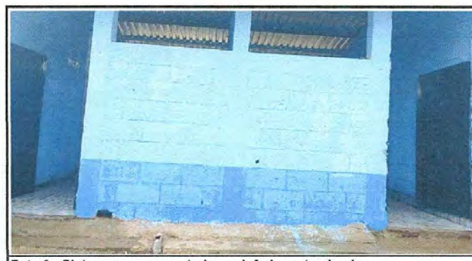
Foto 6 : Pintura en muros exteriores e interiores terminado.
