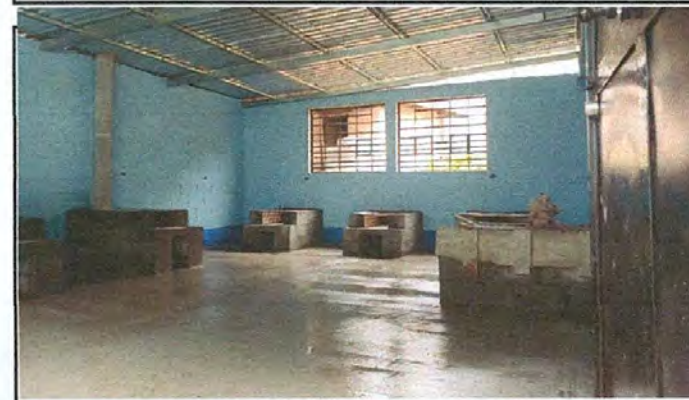
Foto 10: REPARACIÓN DE COCINA: Sustitución de plancha de metal de 3 hornillas finalizado.
