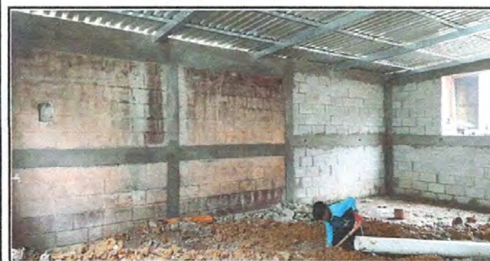
Foto 5: PISO: se continúa con el trabajo en la reparación de piso de torta de cemento.
