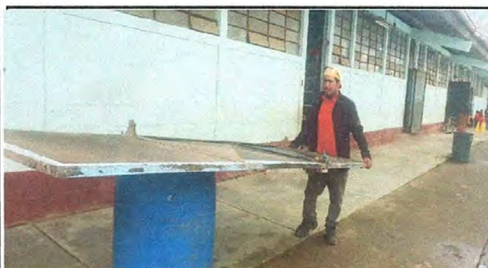
Foto 3: PUERTA DE METAL: Se están quitando las puertas, para la sustitución de la nuevas puertas.
