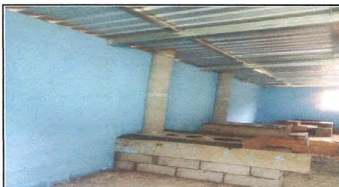
Foto 10: REPARACIÓN DE COCINA: Sustitución de nueva plancha
