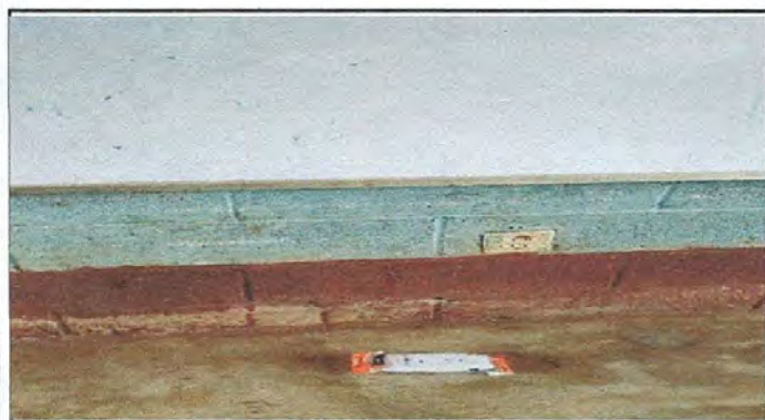
Foto 9: REPARACIÓN DE SISTEMA ELÉCTRICO: cambio de nuevo tomacorriente.
