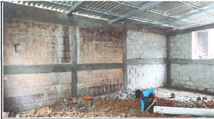
Foto 8: REPARACION DE DRENAJE Y RED DE AGUA POTABLE: Sanjeado y colocación de nuevas tuberías.
