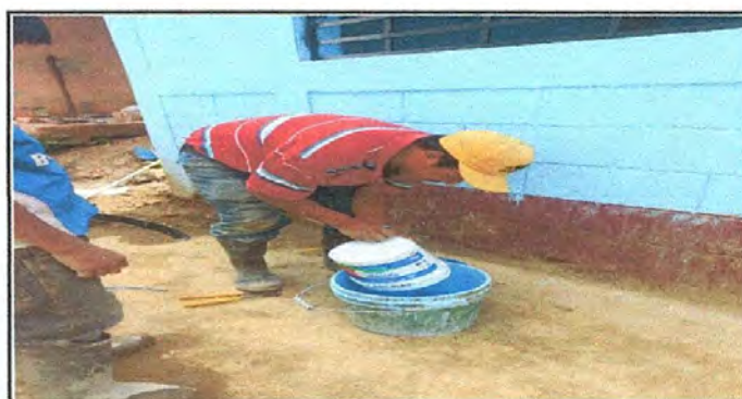
Foto 6: PINTURA: se continuas con la pintura de la cocina
