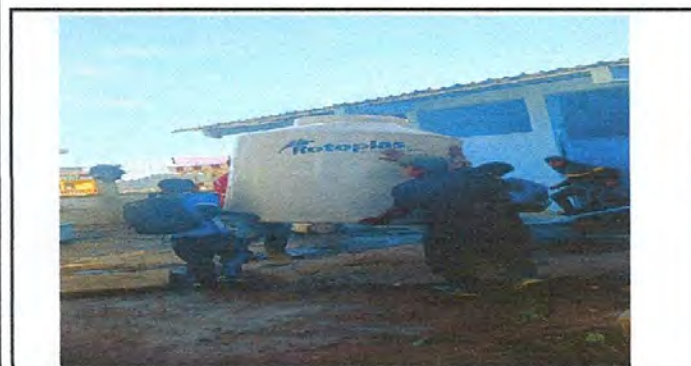
Foto 11: REPARACION Y MANTENIMIENTO DE CISTERNAS: colocacion del nuevo rotoplas que sustitula el anterior.
