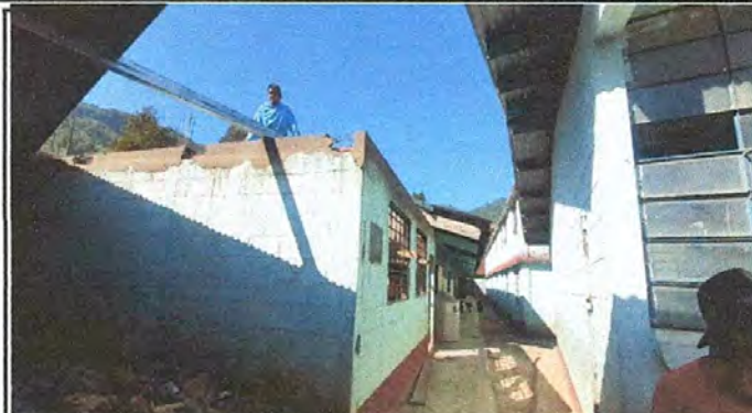
Foto 2: ESTRUCTURA DE TECHO: Se están colocando las costaneras de metal
