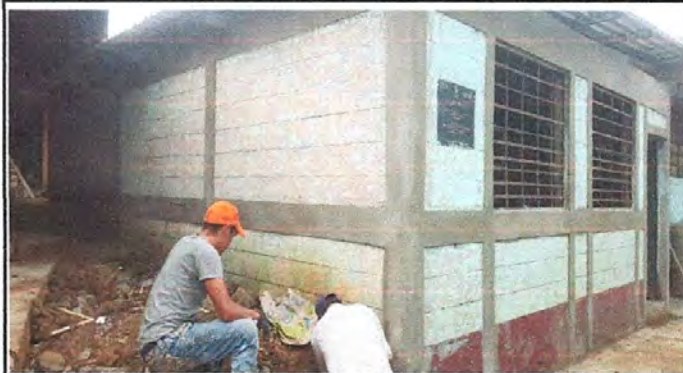
Foto 8: REPARACION DE DRENAJE Y RED DE AGUA POTABLE: Sustitución de tubería por drenaje en mal estado.
