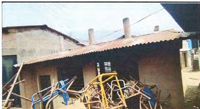
Foto 1: LAMINA sustitución de lamina por lamina troquelada ya que se encuentran en mal estado.
