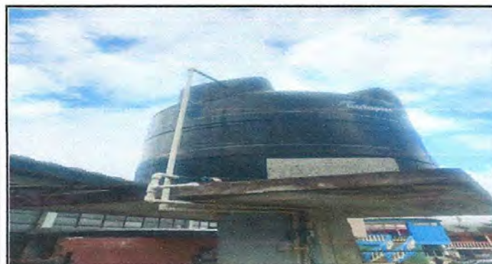
Foto 11: REPARACION Y MANTENIMIENTO DE CISTERNAS: Sustitución de depósito de agua, tinaco.
