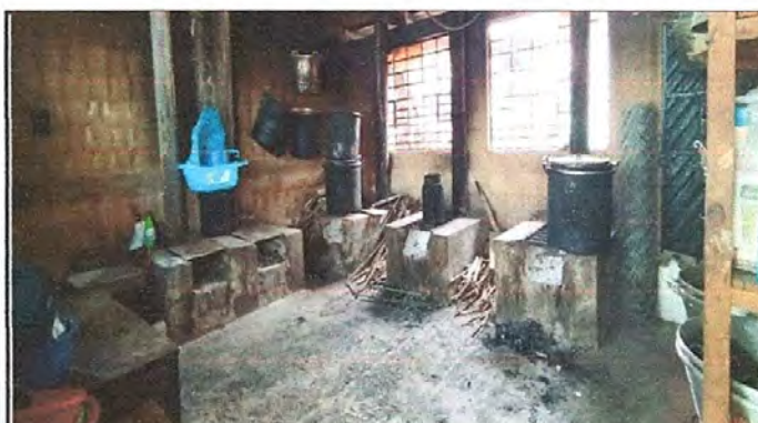
Foto 10: REPARACIÓN DE COCINA: Sustitución de plancha de metal.
