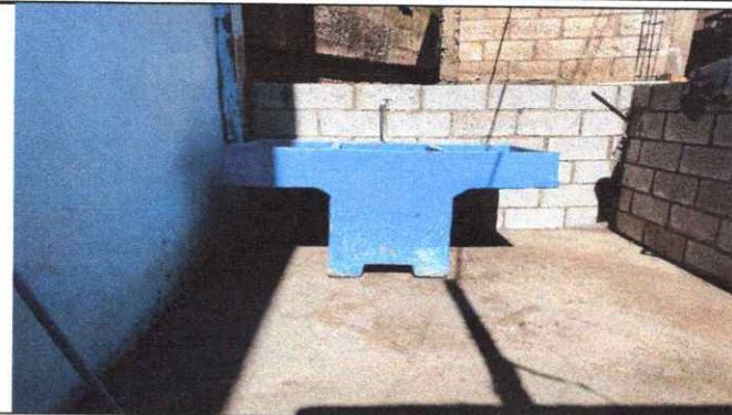
Foto 2: colocación de una pila de cemento con dos lavaderos
