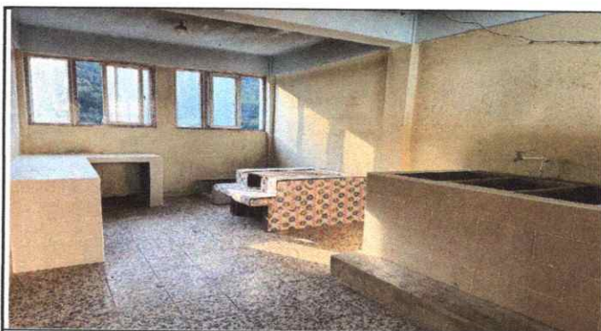
Foto 5: culminación de de mesa de concreto con azulejo, pila de cemento con dos lavaderos plancha con chimenea
