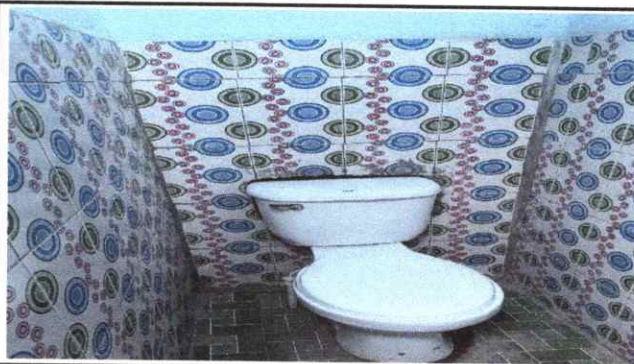
Foto 6: colocación de tasa inodoro para baños
