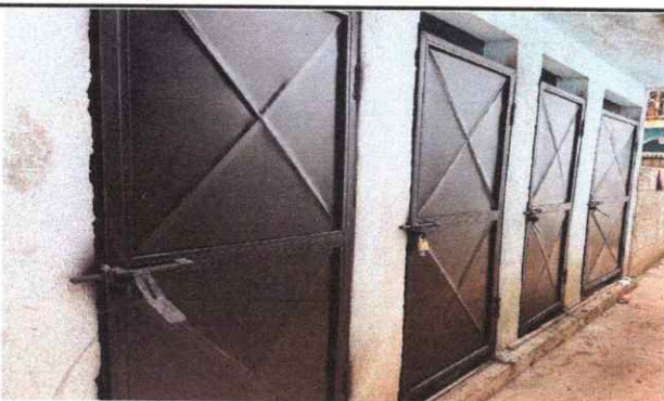
Foto 3: colocación de puertas de metal en baños
