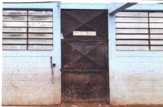
Foto 3: limpieza y cambio de la puertas de las aulas q contiene los renglones de trabajo
