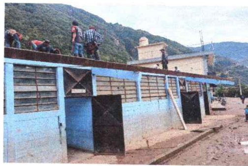
Foto 2: En la imagen se observa la limpieza de las costaneras del techo para lamina del centro educativo
