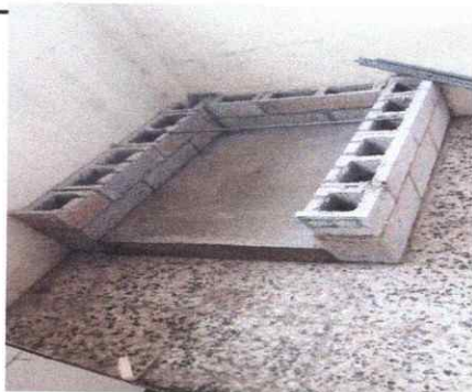
Foto 5: elaboración de fogones para plancha
