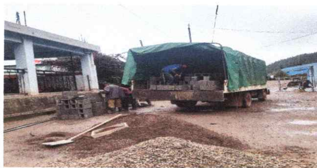
Foto 3: recepción de materiales arena, block, piedra y cemento para la elaboración de renglones
