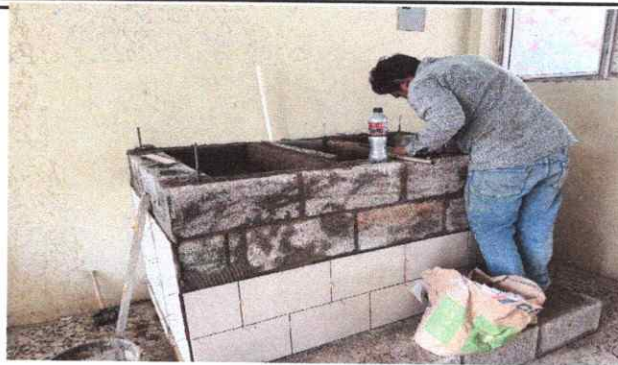
Foto 2: Elaboración de pila fundida de dos lavaderos en cocina del centro educativo
