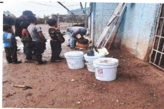
Foto 4: preparación de la pintura para pintar muros exteriores e interiores
