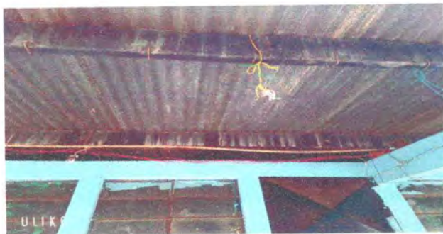
Foto 3: en la fotografía se observa las estructura de soporte de techo de metal ya muy deteriorada, por lo cual se pretende darle mantenimiento a cada uno.
