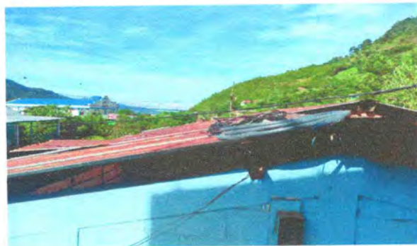
Foto 2: En la imagen se observa el capote deteriorado e inservible
