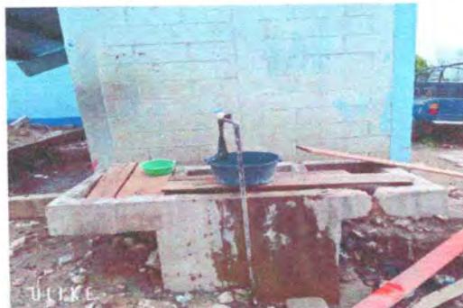
Foto 6: En la imagen se observa una pila en mal estado con sus lavaderos descascarados y su estructura con grietas .
