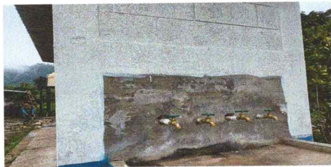
Foto 5: Sustitución de lavamanos en mal estado
