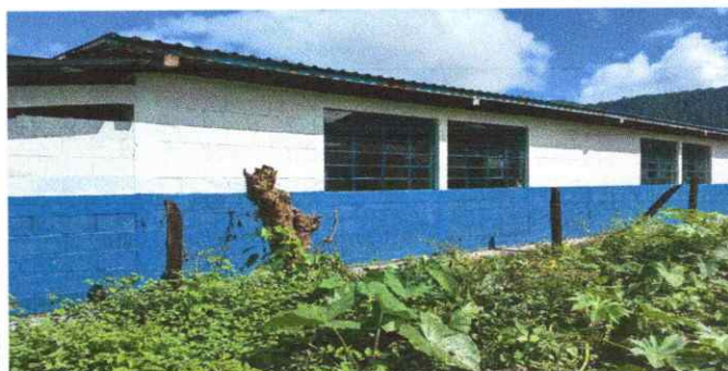
Foto 12: pintura muros exteriores
