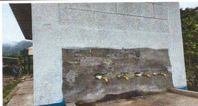
Foto 9: Sustitucion de llaves de agua en malas condiciones
