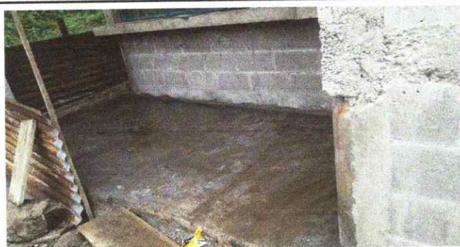
Foto 3: Reparación de piso de torta de cemento en malas condiciones
