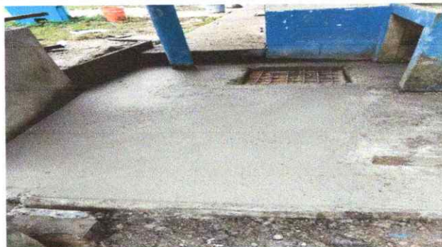
Foto10: Reparación de torta de cemento en malas condiciones
