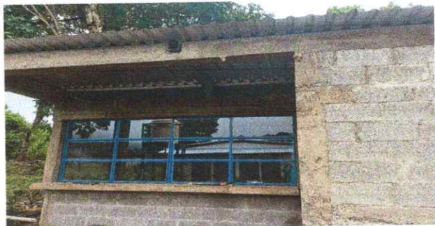
Foto1: Mejoramiento paredes de cocina
