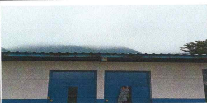
Foto 11: Sustitución de cubierta de laminas de aulas
