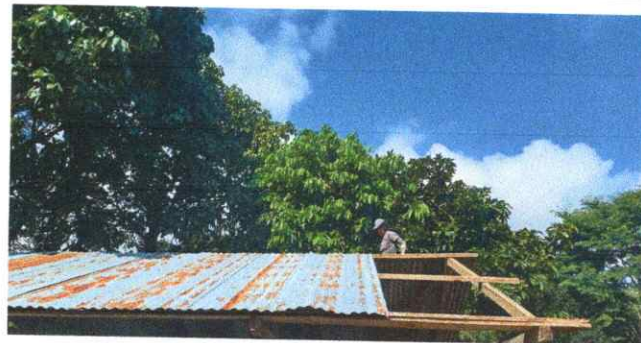
Foto 2: Sustitución de cubierta de Lámina y estructura de techo
