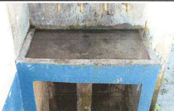
Foto 9: Sustitución de llaves de agua en malas condiciones
