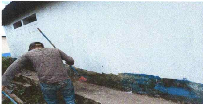
Foto 12: pintura muros exteriores
