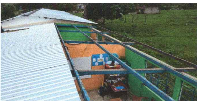
Foto 11: Sustitución de cubierta de laminas de aulas
