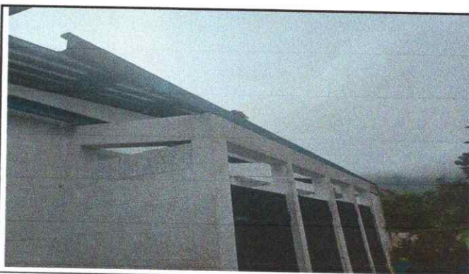
Foto 4: Sustitución de cubierta de lamina y estructura de techo
