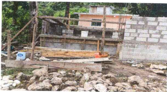
Foto 1: Mejoramiento paredes de cocina
