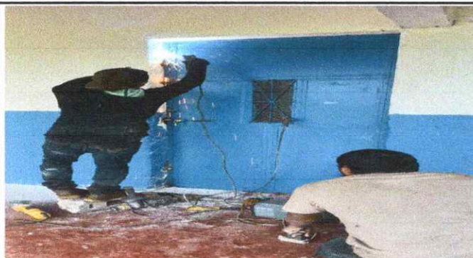
Foto7: Sustitución de chapas de puertas en malas condiciones
