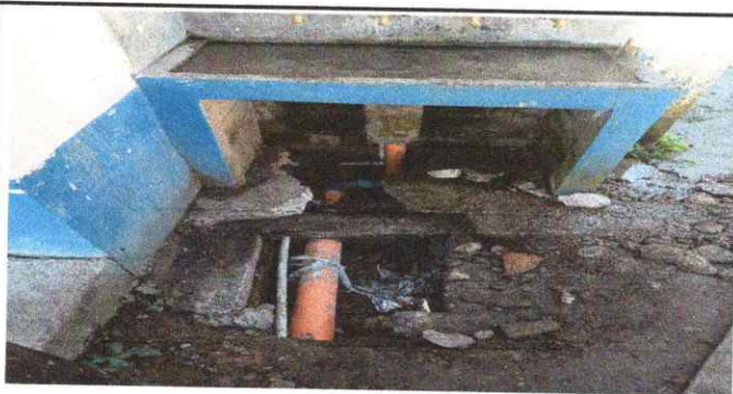
Foto 5: Sustitución de lavamanos en mal estado
