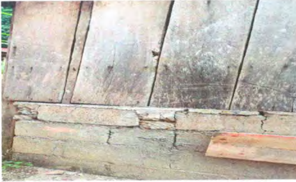
Foto 1: Mejoramiento paredes de cocina
