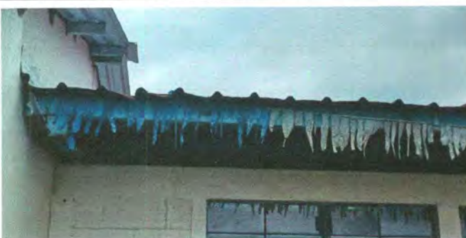
Foto 11: Sustitución de cubierta de laminas de aulas
