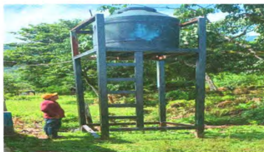
Foto 8: Reparación de base de soporte para tanque de almacenamiento de agua
