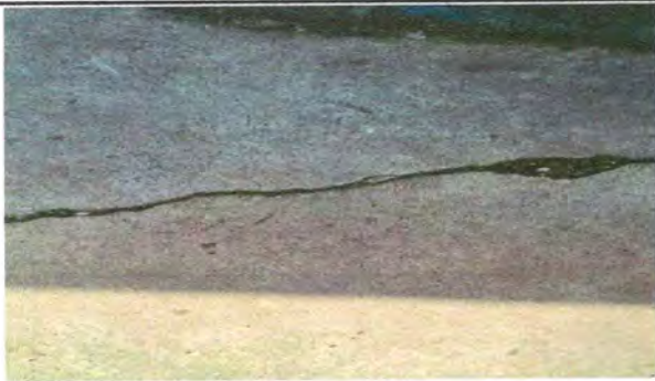
Foto 3: Reparación de piso de torta de cemento en malas condnciones
