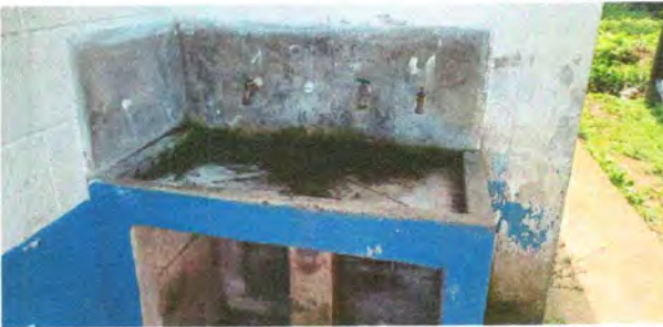
Foto 5: Sustitución de lavamanos en mal estado
