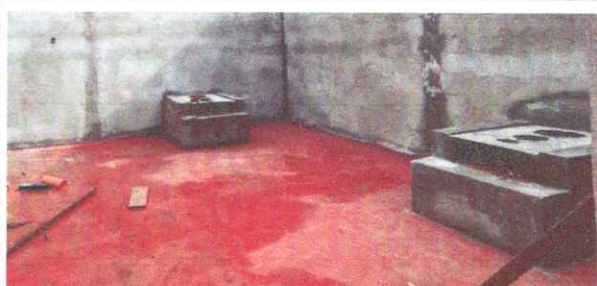
Foto 3: Sustitución de fogon en mal estado
