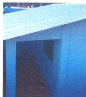
Foto 2: Sustitución de láminas dañadas o en malas condiciones
