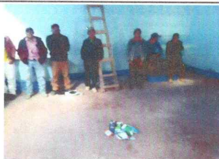
Foto 4: Sustitución de piso de granito dañado
