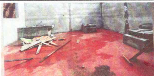
Foto 4: Sustitución de piso de granito dañado
