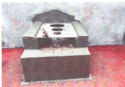
Foto 3: Sustitución de fogon en mal estado
