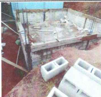
Foto 1: Mejoramiento de pared de madera a block en cocina
