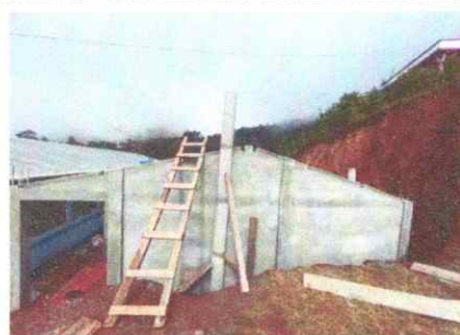
Foto 6: Sustitución de chimenea y plancha en mal estado
