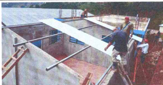
Foto 2: Sustitución de láminas dañadas o en malas condiciones
