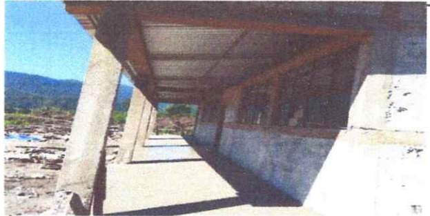
Foto 4: Sustitucion a estructura de soporte de madera a metal
