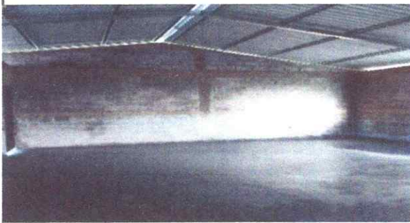
Foto 3: Sustitución de piso de Cemento líquido
