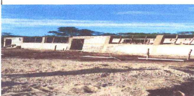
Foto 5: avance de edificio escolar
