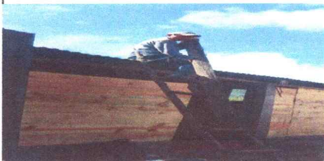
Foto 3: Sustitucion de láminas
