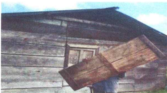
Foto1: Sustitucion de puertas
